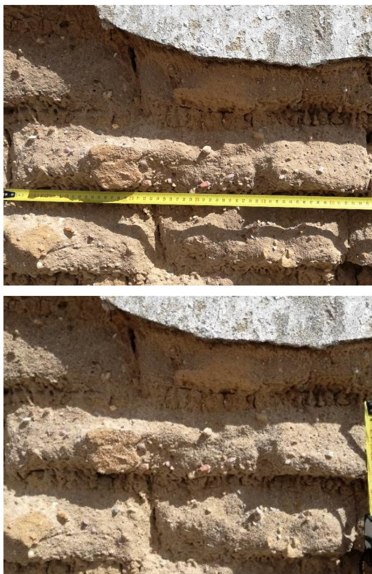
Figura 3.5 – Adobes da casa 195.
