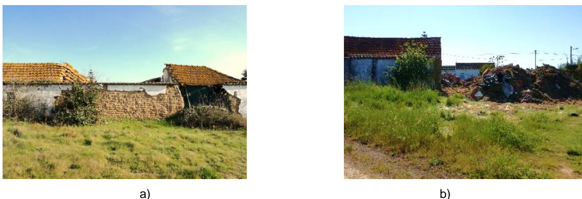
Figura 4.1 – Casa 218: a) antes da demolição e b) após a demolição.
