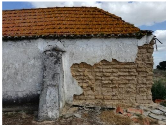
Figura 3.4 – Casa 195: contraforte e ancoragens passivas na fachada oeste.
