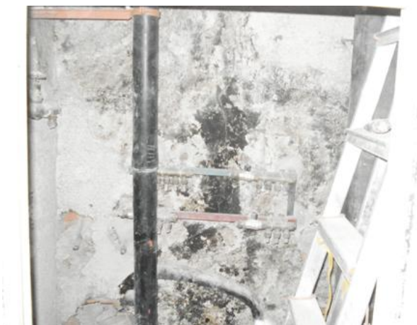
Figura A.33 – Revestimento interior de uma courette (Interamianto, 2007b)
