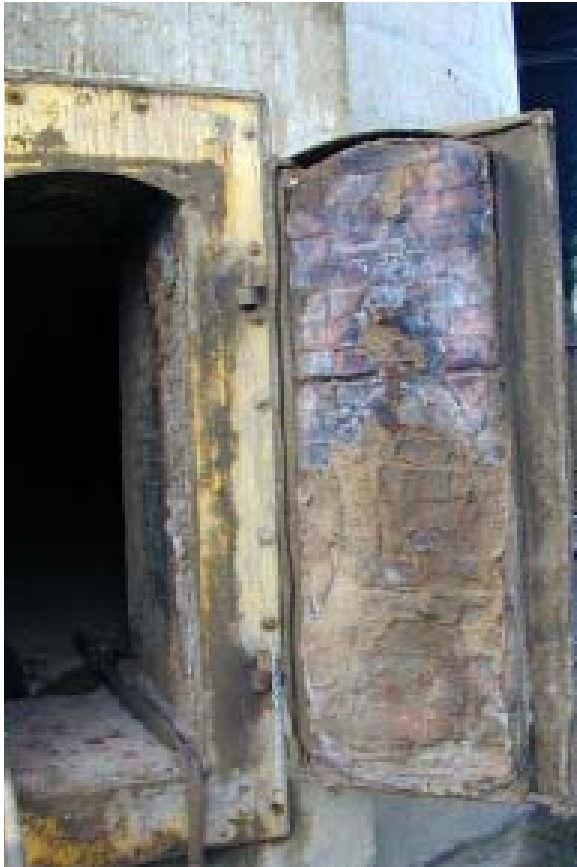
Figura A.31 – Selagem com cordão de amianto numa porta de chaminé (CARIT, 2006)
