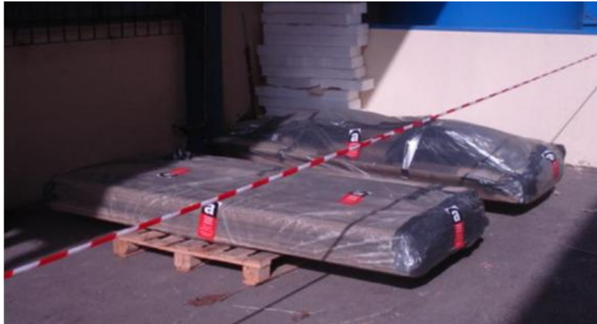
Figura 2.5 – Placas de fibrocimento retiradas inteiras e acondicionadas
