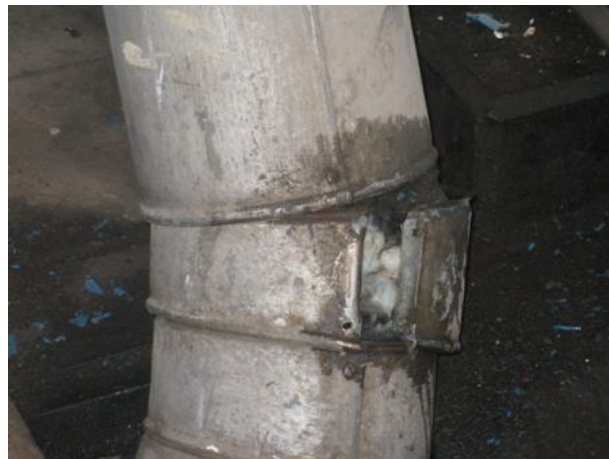
Figura A.36 – Isolamento térmico de conduta
