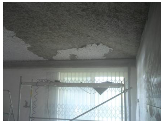
Figura A.34 – Revestimento de tecto (Interamianto, 2007b)
