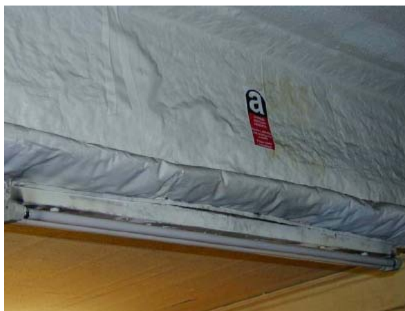
Figura A.28 – Estrutura de aço com isolamento de amianto (protecção ignífuga) (CARIT, 2006)
