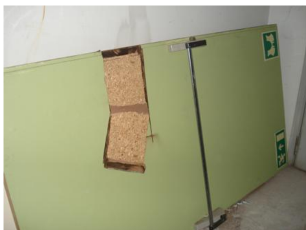
Figura A.30 – Interior de porta corta-fogo (Interamianto, 2007b)
