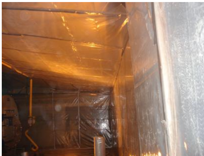
Figura 4.11 – Interior da zona de trabalho confinada
