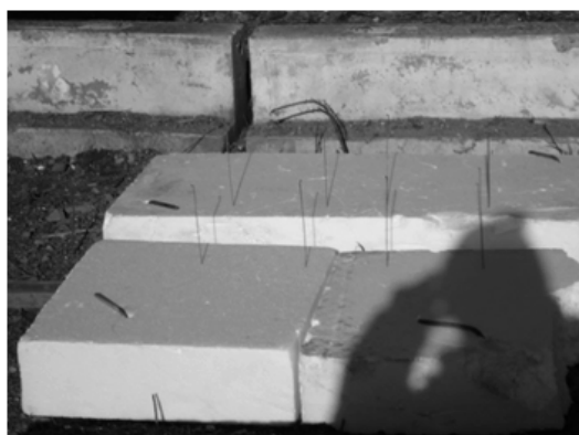
Figura 3.20: Colocação das hastes nas placas de poliestireno expandido
