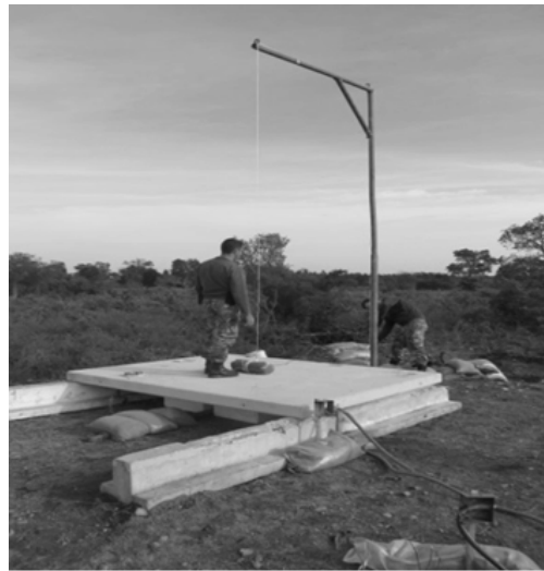
(b) Colocação de carga explosiva
