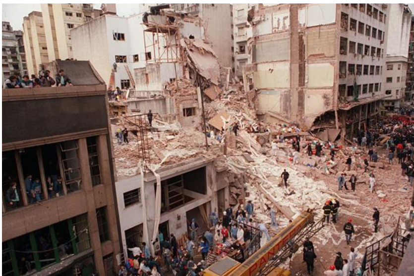
Figura 1.6: Danos causados pela explosão no edifício da AMIA, Argentina [3]
