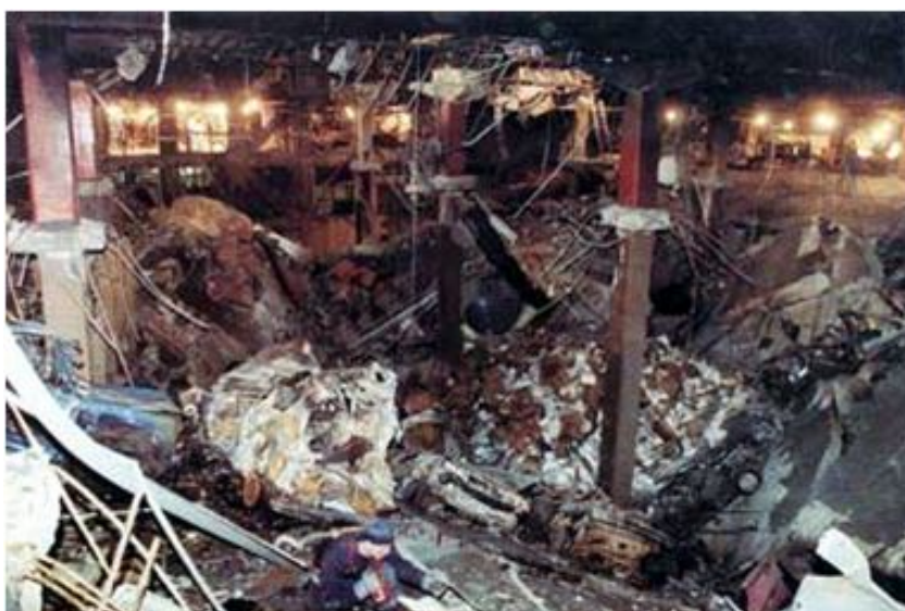
Figura 1.1: Destruição do parque de estacionamento do World Trade Centre, EUA (Adaptado de [54])
