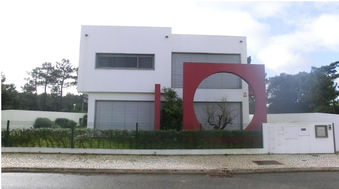
Fig. 4.2 Vista da fachada principal da habitação em estudo
