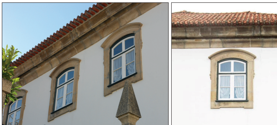
Fig. 4 – Casa das Obras, Manteigas (Guarda). Fachada principal, pormenor de vão do piso nobre Fonte: Fotografia da autora, 2017
