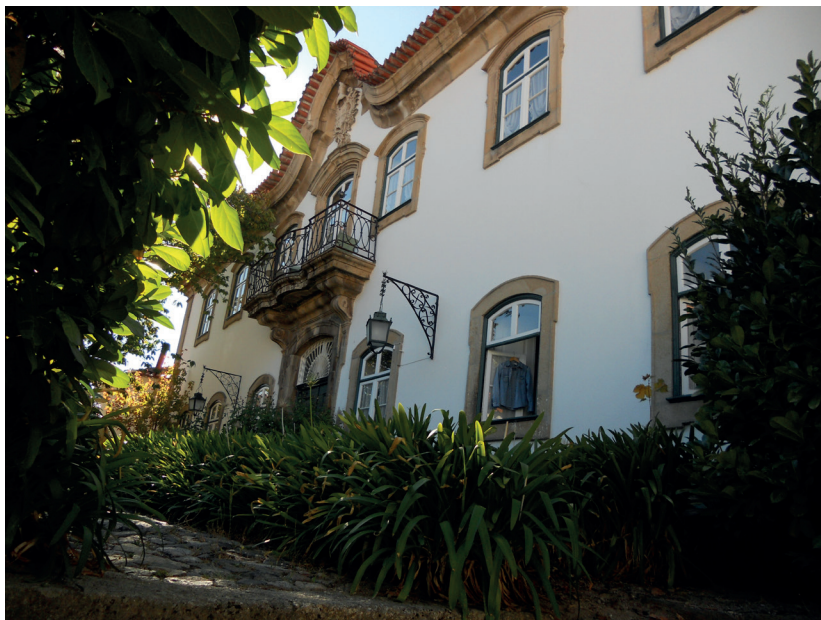
Fig. 1 – Casa das Obras, Manteigas (Guarda). Fachada principal Fonte: Fotografia da autora, 2017
