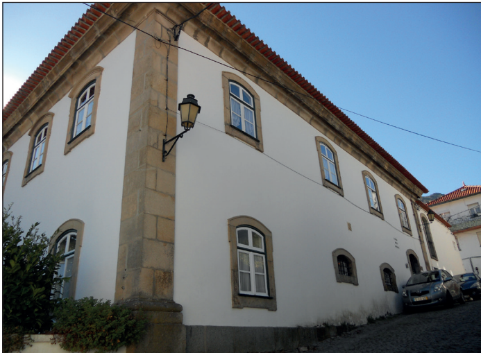
Fig. 6 – Casa das Obras, Manteigas (Guarda). Fachada lateral direita (vista de Norte para Sul)
