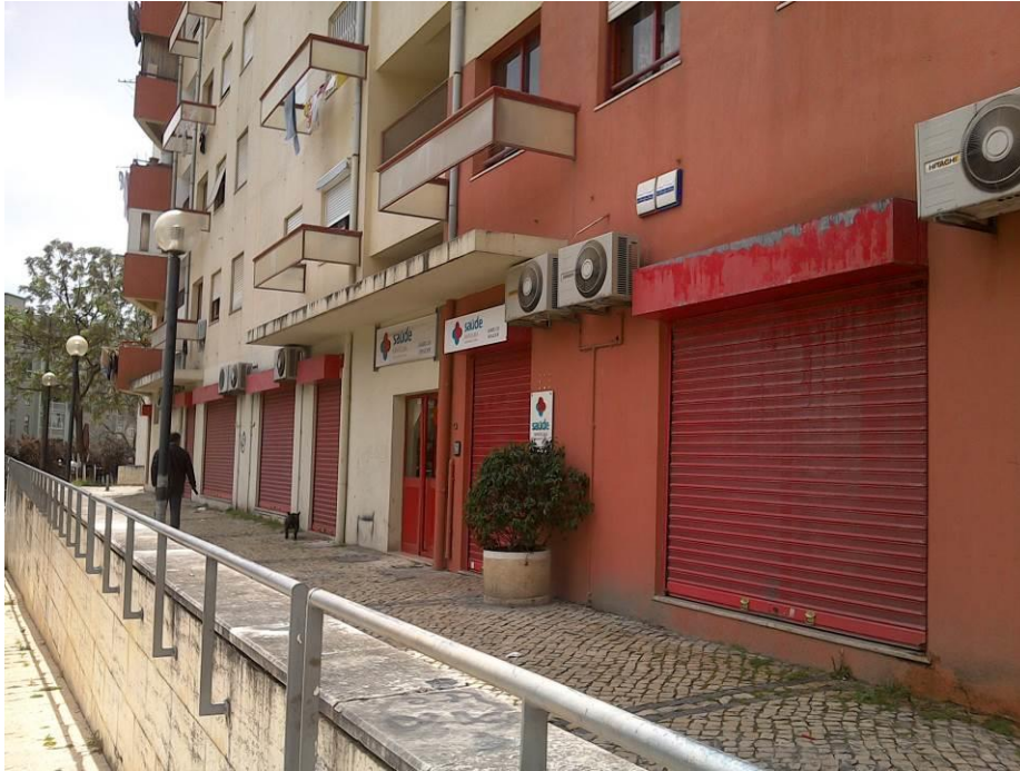
Figura 35: Passeio onde se localiza a CPCJ e onde ficava o gabinete da Gebalis.
