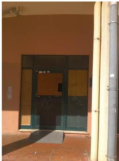
Figura 11: Entrada de um prédio de habitação social
