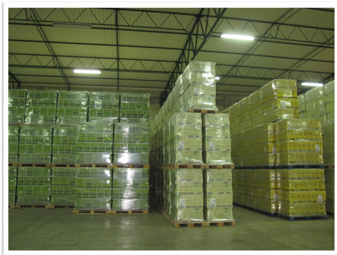
Figura 5.14 - Produto acabado arrumado por paletes no Armazém de Produto Acabado (APA), pronto a ser expedido.
