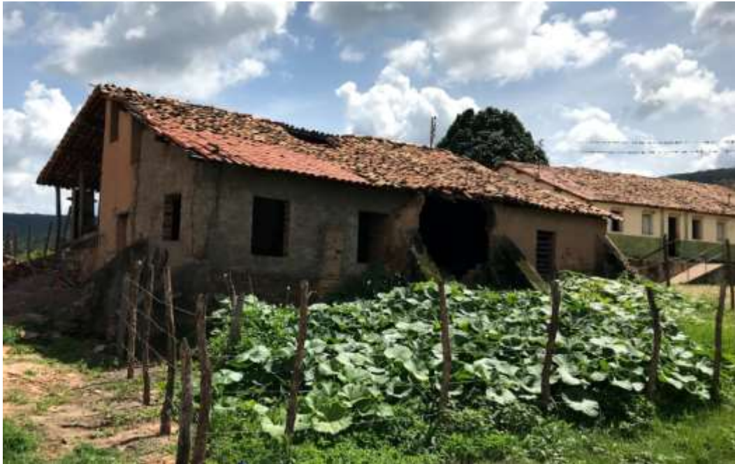
Figura 2.14 Ruínas do engenho Farias. Em segundo plano à direita, a casa, indicando a proximidade Fonte: Acervo da autora
