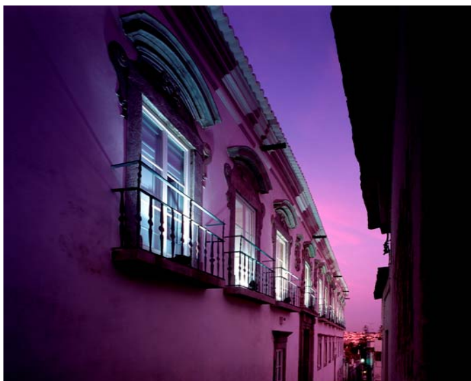
Figura 3 – Palácio da Galeria em Tavira
