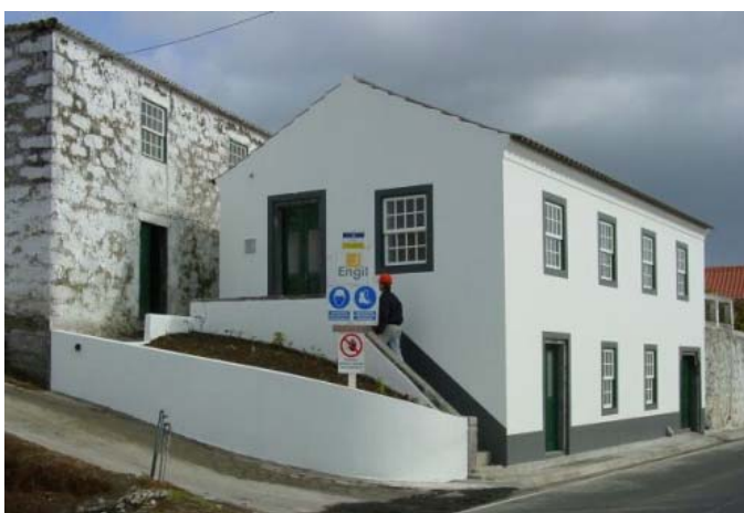
Figura 5 - Moradia na Ilha da Horta – Açores após obras de reabilitação
