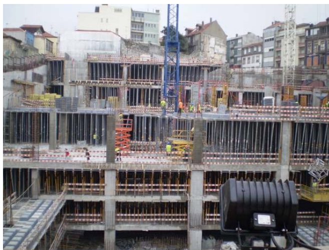
Figura 22 - Centro Comercial Porto Plaza
