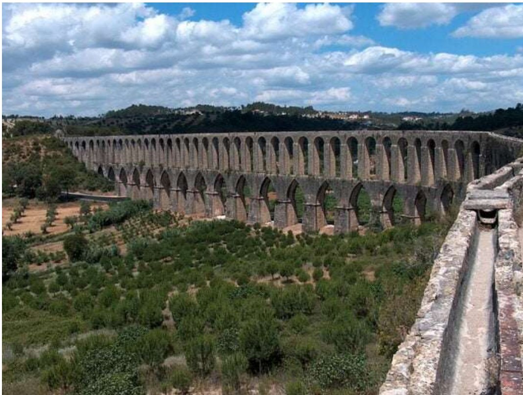
Figura 3 - Aqueduto dos Pegões. Fonte: Carvalho, 2024
