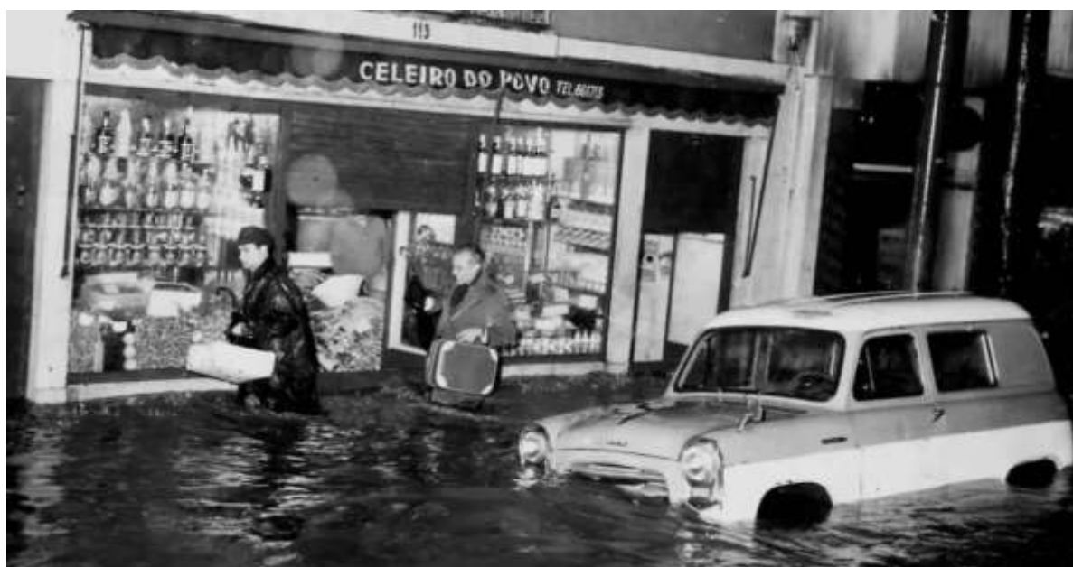
Figura 39 - Inundação de 1967 em Lisboa. Fonte: National Geographic Portugal, 2017
