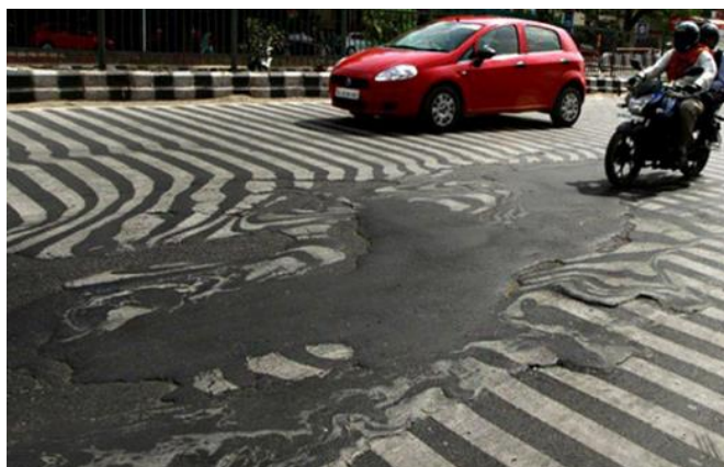
Figura 2.8 - Pavimento de uma estrada da Índia, durante uma vaga de calor (Exame Informática, 2015)
