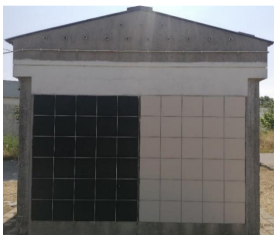
Figura 3.8 — Disposição dos ladrilhos cerâmicos no exterior da parede oeste.
