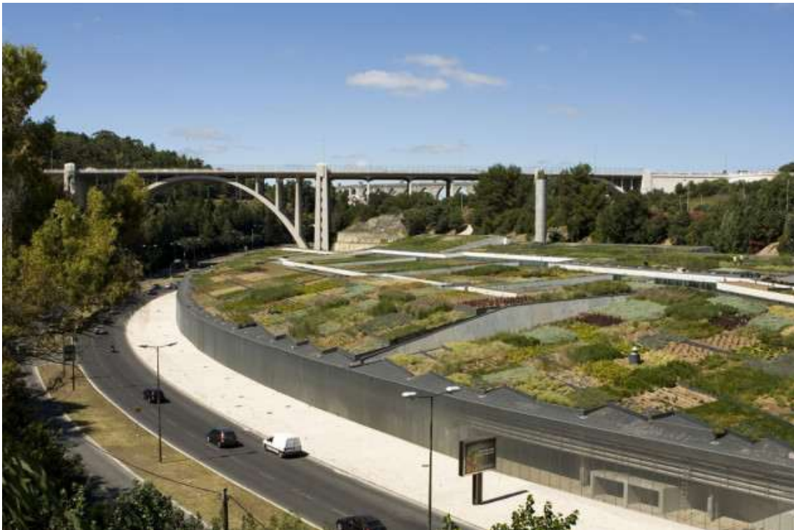
Figura 8: Telhado Verde da ETAR de Alcântara, Lisboa Fonte: proap
