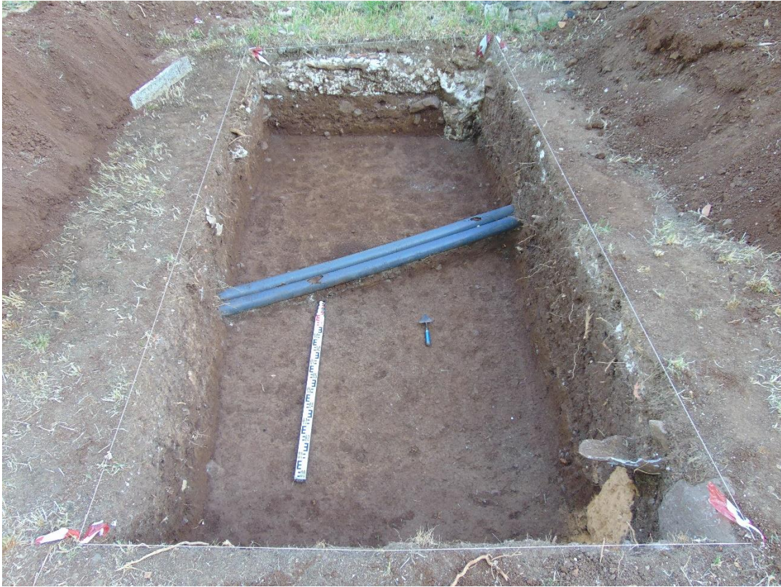
Foto 19 – Plano final da Sondagem 1. Existência de tubos de PVC e da fundação do muro no corte norte.
