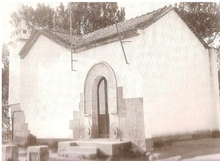
Figura 2.8 – Escola Rogério de Azevedo [18]
