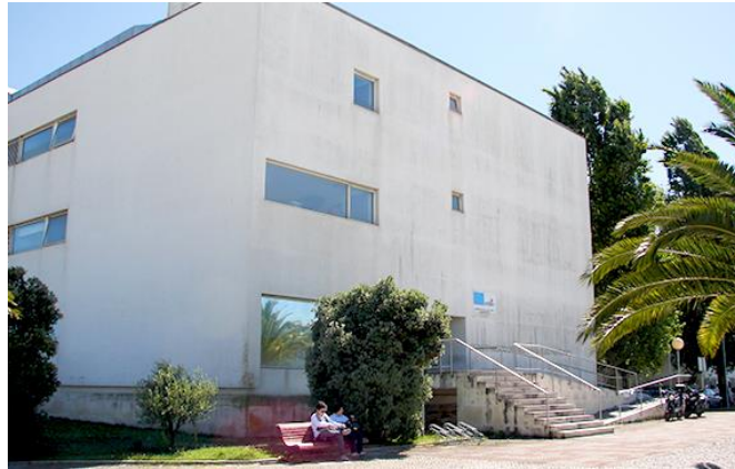
Fig. 4.1 – Edifício do DEEC da FCT-NOVA
