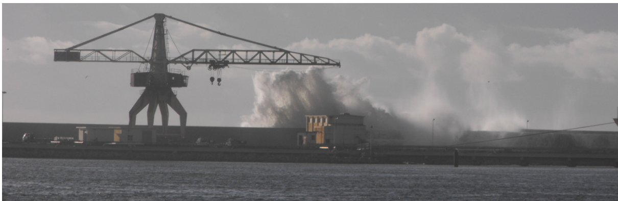
Figura 2.14: Galgamento do molhe norte do Porto de Leixões no dia 20 de fevereiro de 2014.
