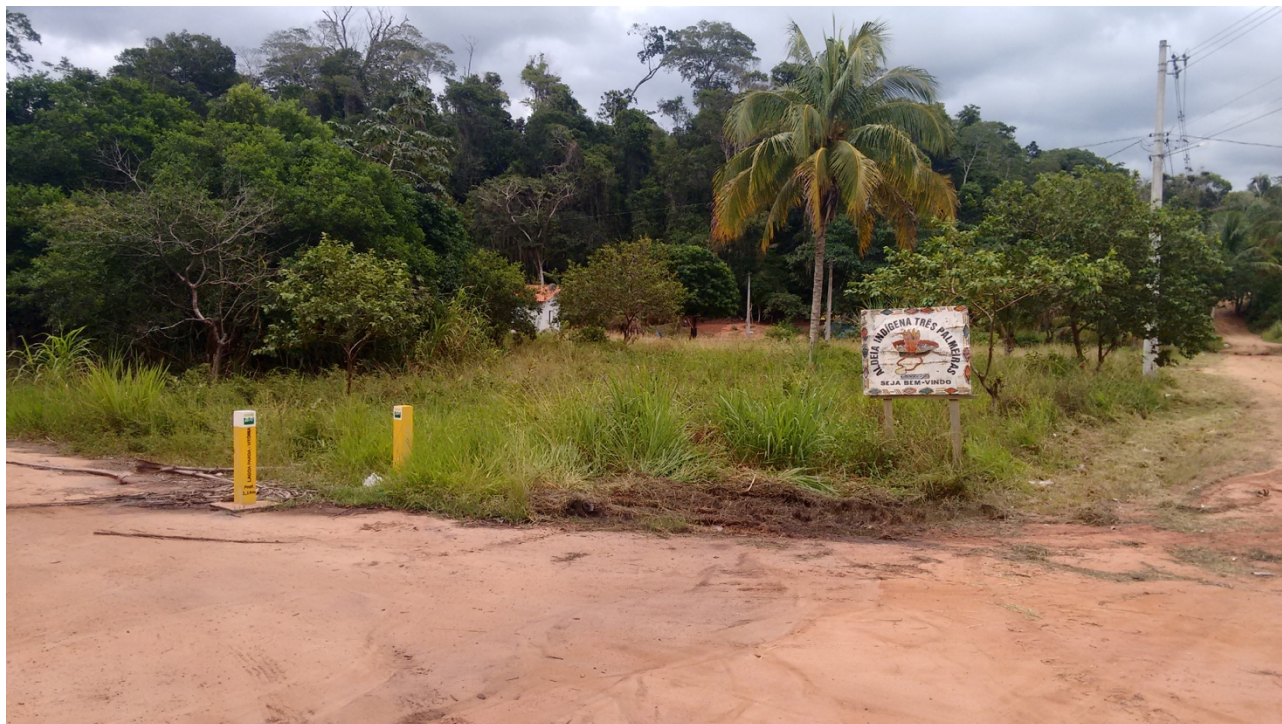
Foto 16: Gasoduto Lagoa Parada-Vitória em Aracruz, próximo à aldeia Três Palmeiras
