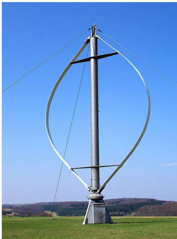
Figura 3.4 – Turbina eólica do tipo Darrieus.
