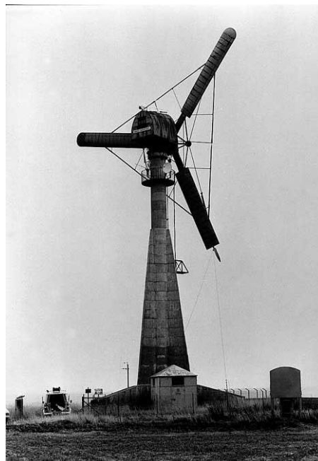
Figura 3.6 – Turbina eólica Gedser na Dinamarca
