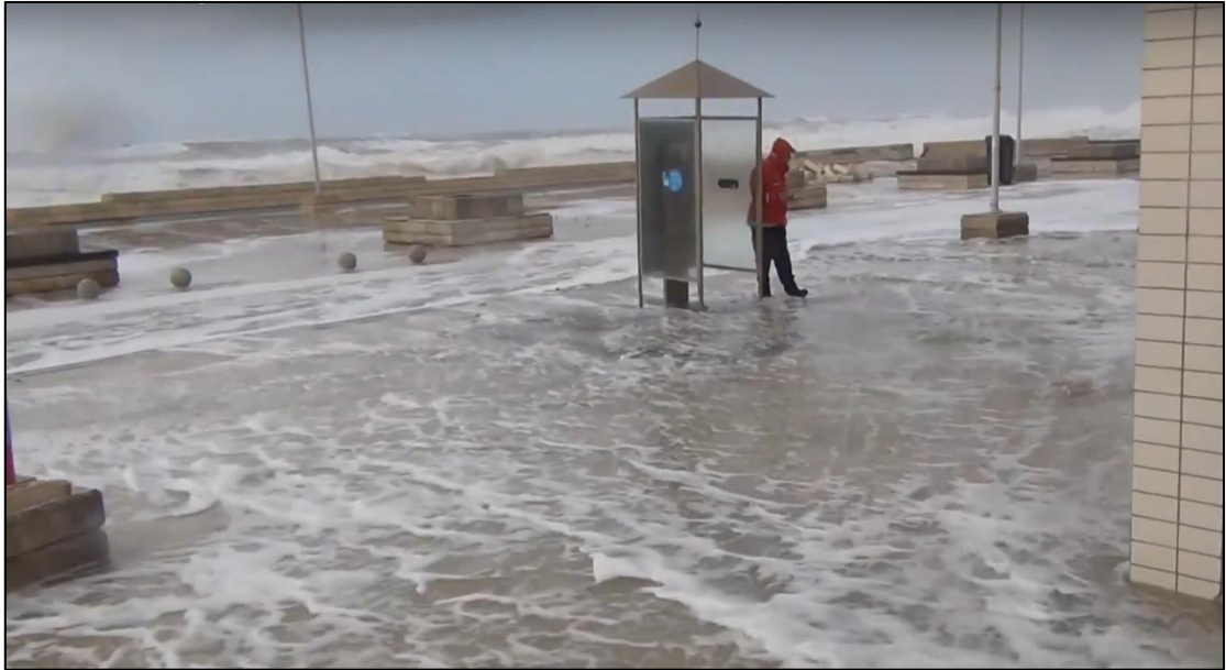
Figura 3.33 Estruturas de defesa comprometidas. Fonte: José Monteiro, 2014.
