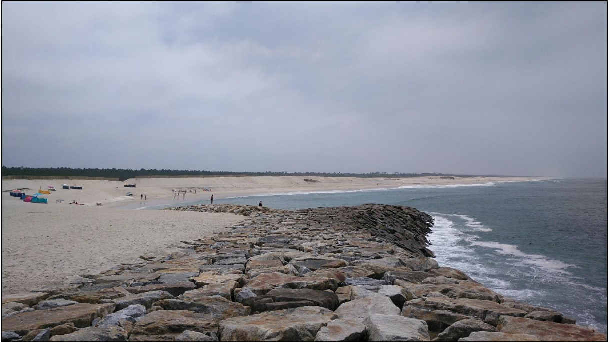
Figura 3.29 Extremidade Sul da obra longitudinal aderente do Furadouro. Fonte autor, 2018.
