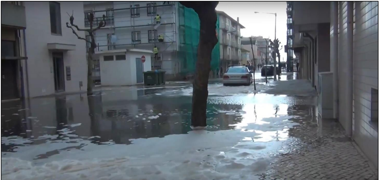
Figura 3.34 Inundação no aglomerado urbano. Fonte: José Monteiro, 2014.
