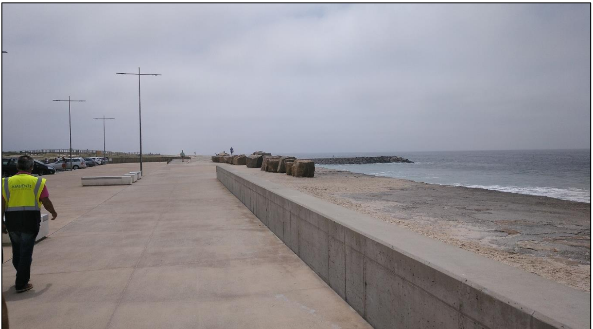
Figura 3.30 Muro e blocos rochosos na parte Sul da frente urbana do Furadouro. Autor, 2018.
