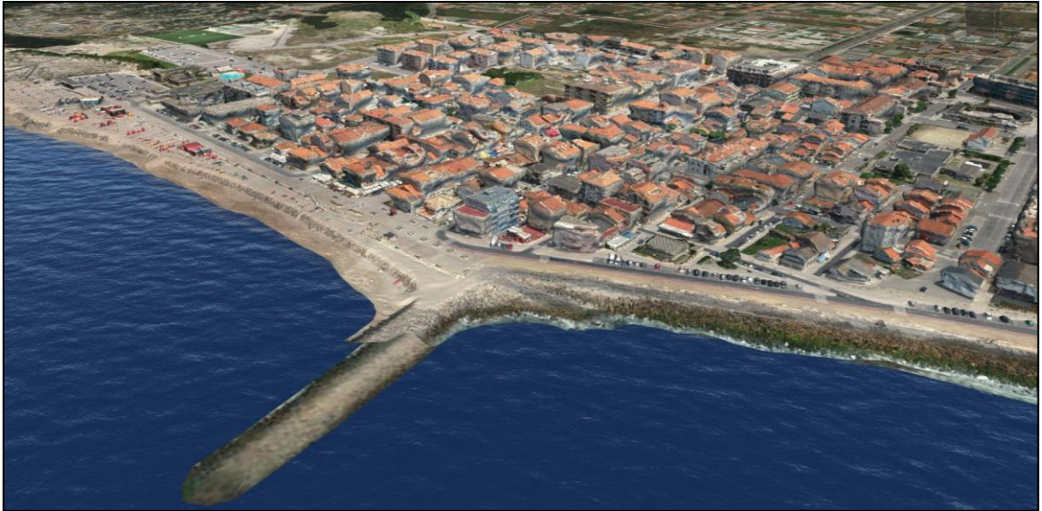
Figura 4. 31 Vista do Furadouro em 3D, nuvem de pontos obtida através de VANT.
