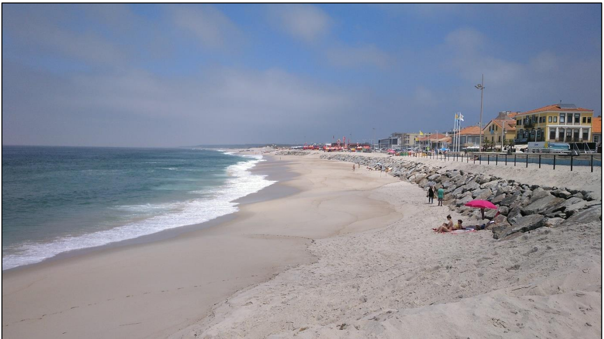
Figura 3.28 Obra longitudinal aderente a Norte do esporão Norte do Furadouro. Fonte: Autor, 2018.
