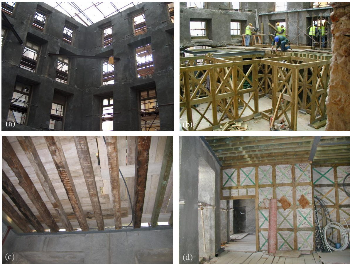
(a) – vista geral do reforço das paredes periféricas no interior do edifício; (b) – nova estrutura interior do edifício (novas paredes de frontal e novo pavimento); (c) – reutilização de secções de vigas de madeira em bom estado; (d) – preenchimento dos frontais com telhas cerâmicas da cobertura
