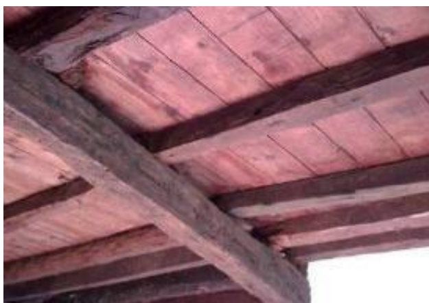
Figura 3.24 – Colocação de viga transversal ao vigamento do pavimento [11]
