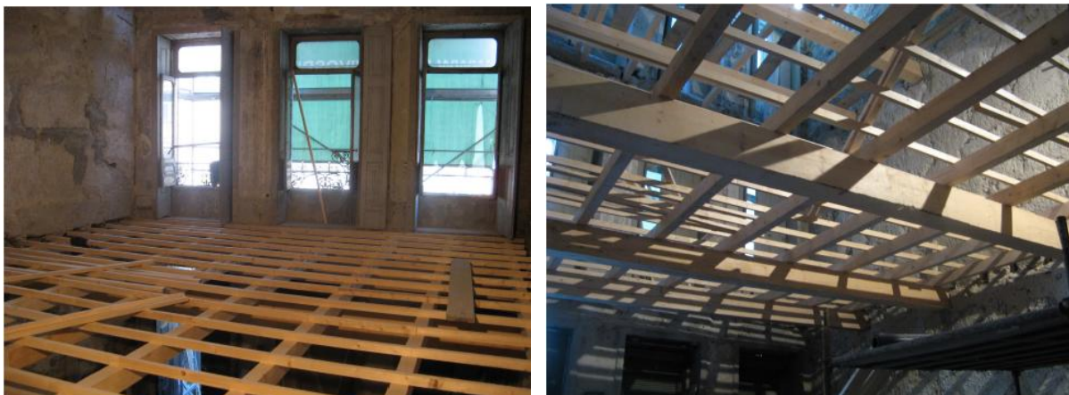
Figura 4.5 – Execução de pavimento elevado de madeira em obra de reabilitação (Edifício na Rua Mouzinho da Silveira) [2]
