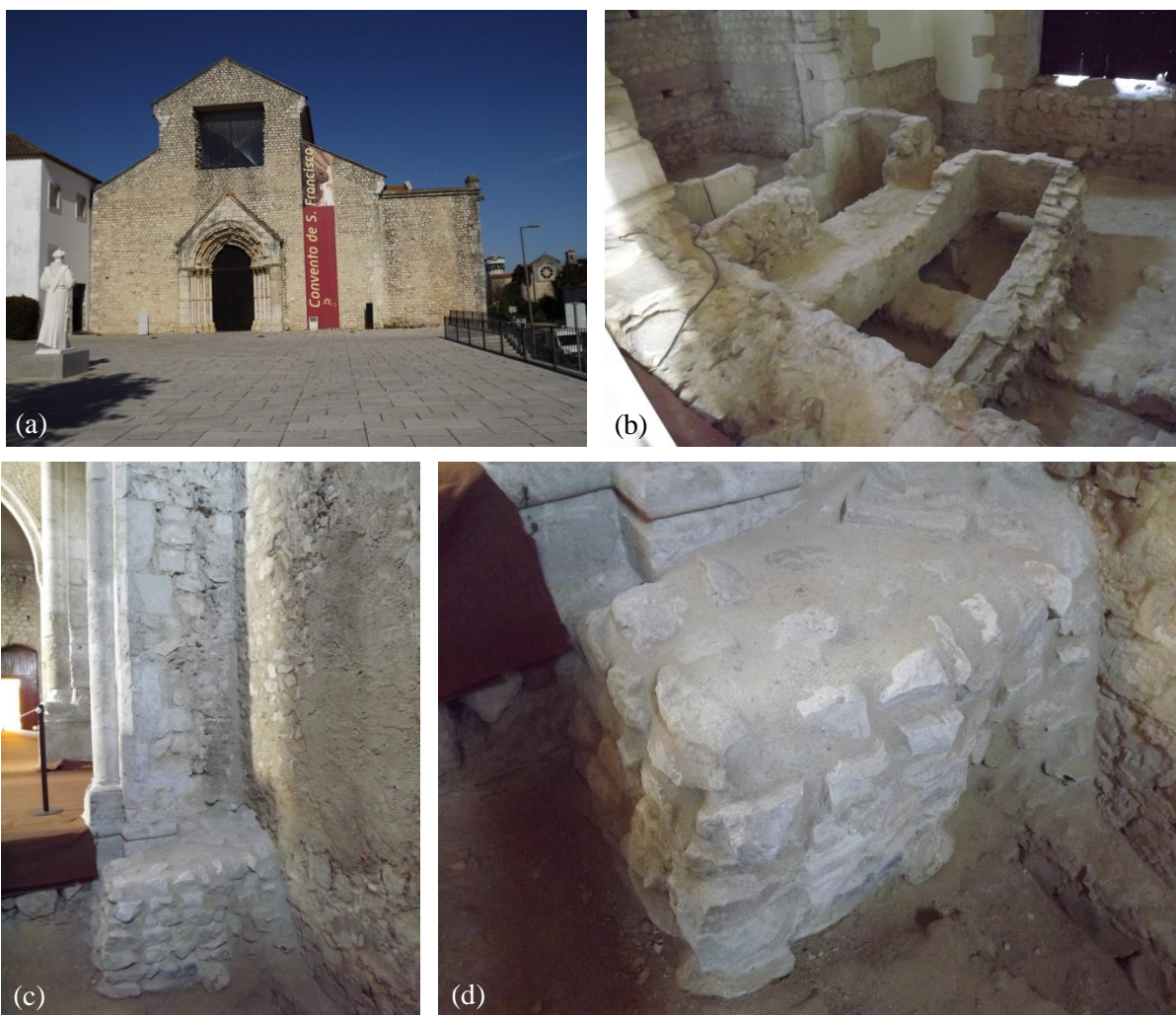
(a) – vista geral do Convento; (b) – vista das sondagens arqueológicas deixadas em aberto; (c) – vista de fundação e respectiva parede resistente; (d) – pormenor de fundação reconstruída com elementos pétreos aproveitados
