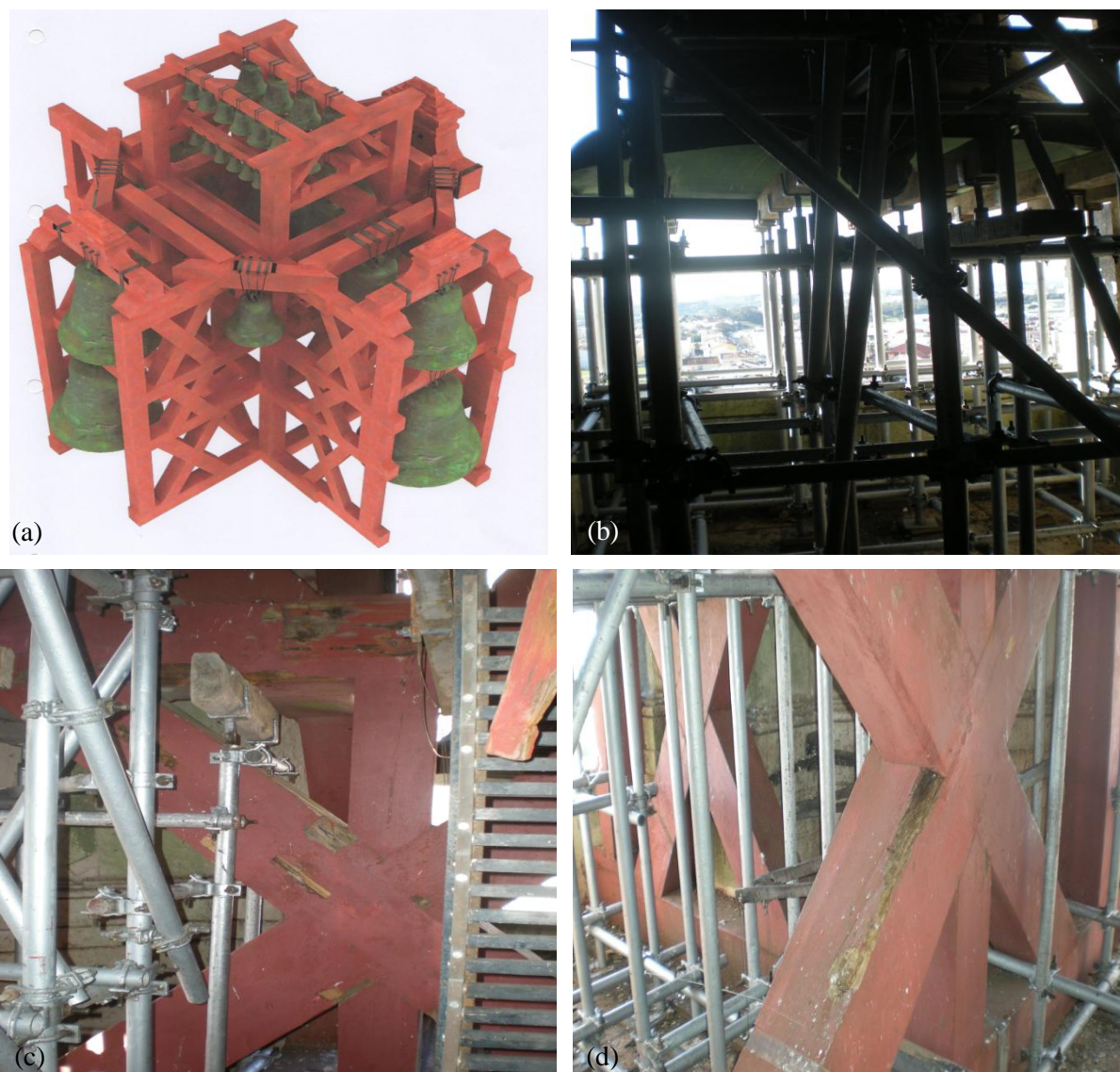
(a) – representação esquemática da estrutura de suporte [69]; (b) – estrutura metálica a sustentar um sino; (c) – estrutura metálica a sustentar a estrutura de suporte de madeira; (d) – pormenor da cruz da estrutura de suporte de madeira
