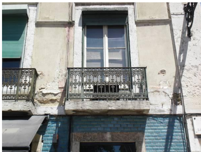
Figura 2.3 – Elementos de cantaria no contorno duma abertura de janela
