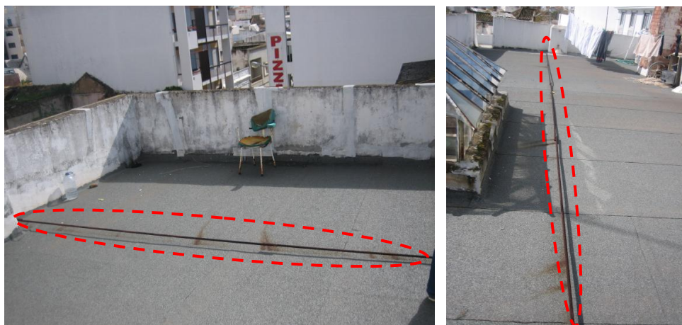
Exemplo de aplicação num edifício em Faro
