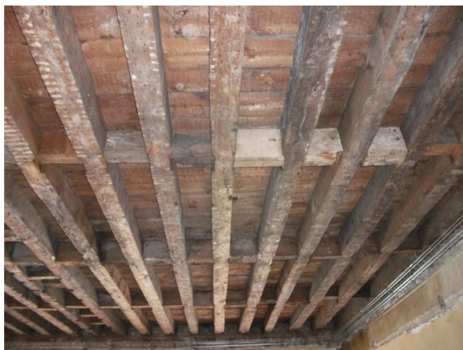
Figura 3.1 – Vigamento dum pavimento de madeira
