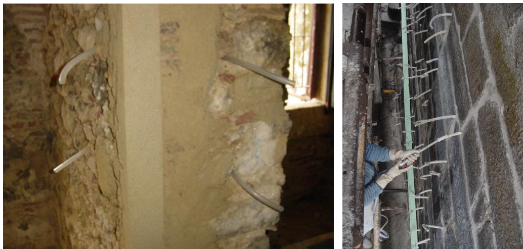
Figura I.5 – Injecção de caldas [92]
