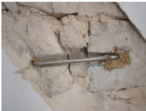
Figura I.18 – Gateamento de fenda com grampo de aço [93]
