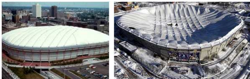
Figura 2.25: Rotura da cobertura do Metrodome Minneapolis [138, 109].
