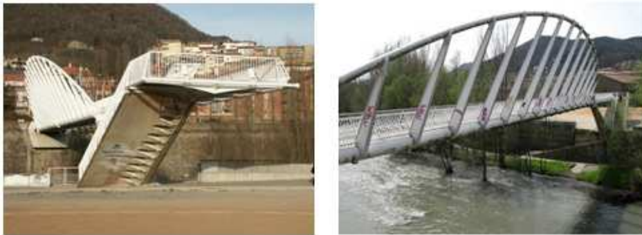
Figura 2.16: Ponte La Devesa, Ripoll, Espanha [149].
