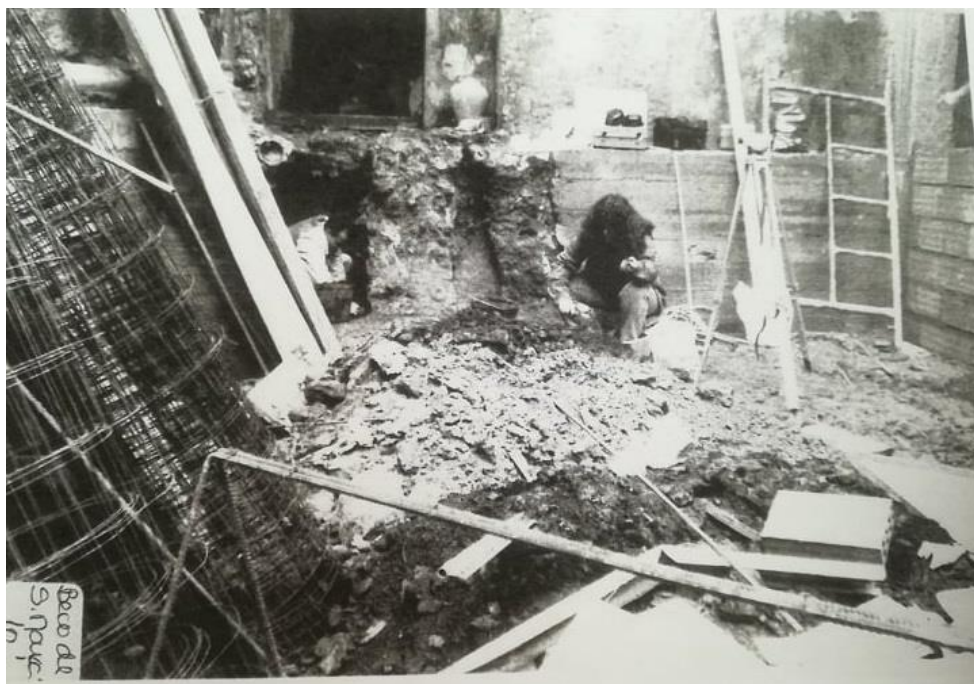
Figura 5. Foto nº10 da intervenção no Beco de São Marçal nº13 C. Muro, trabalhos de escavação de recuo do corte (SABROSA, 2016, p.20, CNS: 35896).
