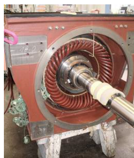
(b) Instalação do rotor SAT na carcaça da máquina de 4 MVA
