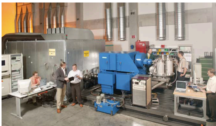
Figura 2.7: Gerador SAT Siemens de 4 MVA no banco de ensaios. Retirado de www.siemens.com .
