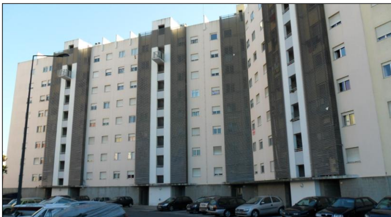
Figura 24 - Edifícios na Rua Bento Gonçalves (n.ºs 23 a 29)
