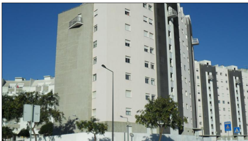
Figura 24.1 - Edifícios na Rua Gilberto Freire (n.ºs 1 a 11)
