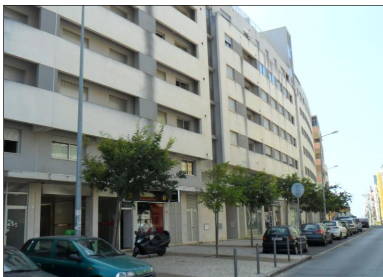
Figura 46 - Edifícios na Rua Vale Formoso de Cima (n.ºs 152 a 158)
