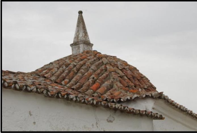
Figura 2 - Pormenor da cúpula da Ermida
