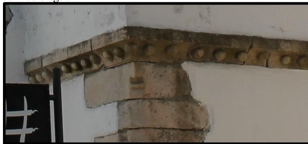
Figura 3 - Pormenor da decoração tardo-gótica da escadaria
