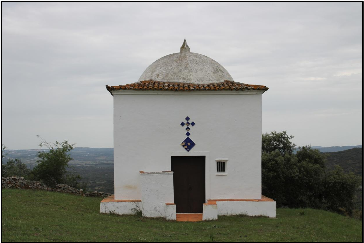
Figura 1- Fachada do Edifício
