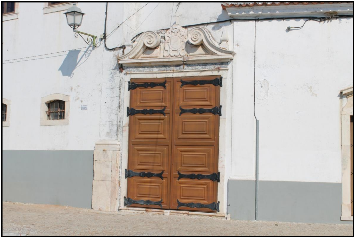
Figura 1- Fachada do Edifício
