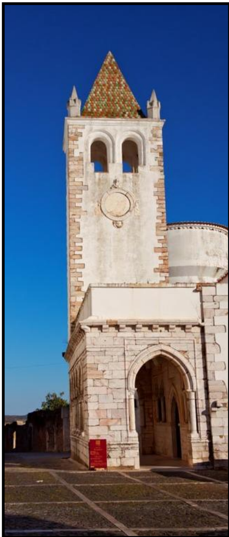
Figura 1- Enquadramento geral do edifício: Galilé e Torre do Relógio
