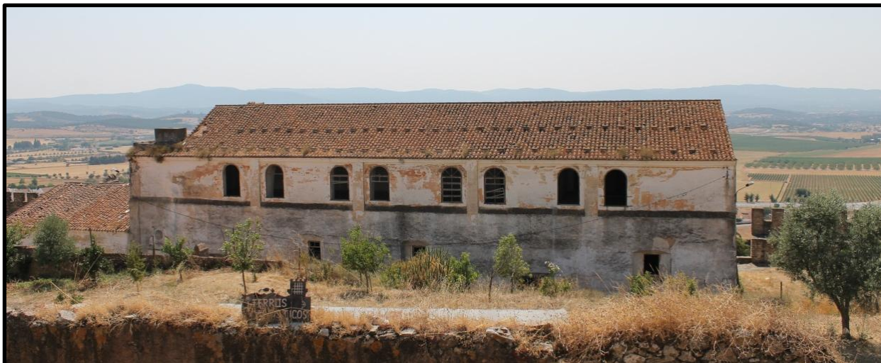
Figura 1- Vista geral do edifício
