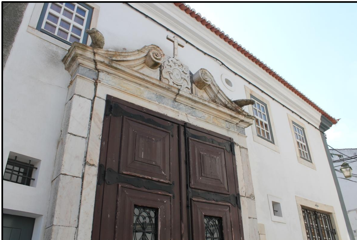
Figura 1- Fachada do Edifício
