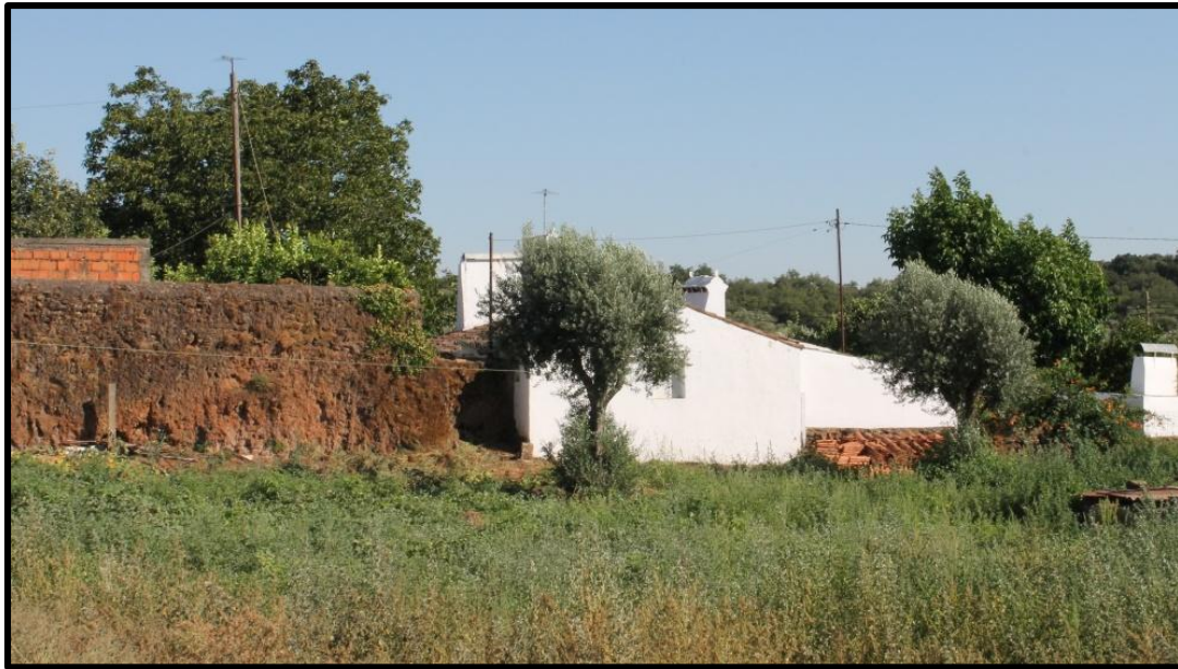
Figura 1- Vestígios do algeroz que conduzia a água até à roda vertical da azenha.
