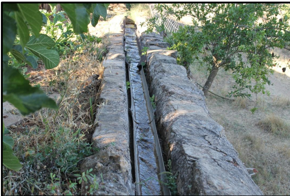
Figura 1- Vestígios do algeroz que conduzia a água até à roda vertical da azenha.
