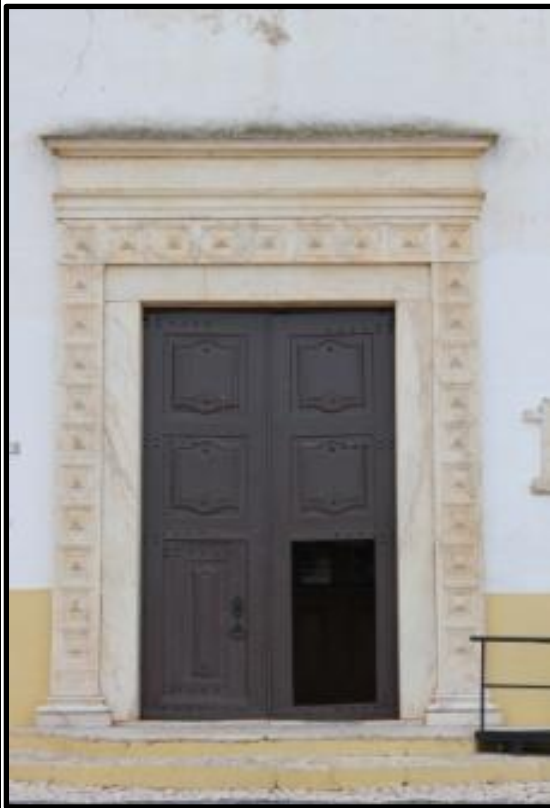
Figura 2- Pórtico da entrada
