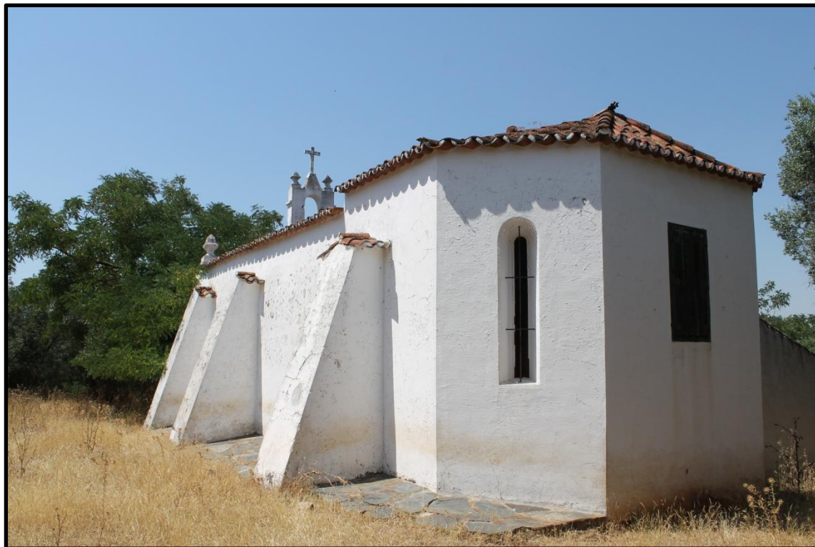
Figura 1- Pormenor da abside e do sistema de contrafortagem
