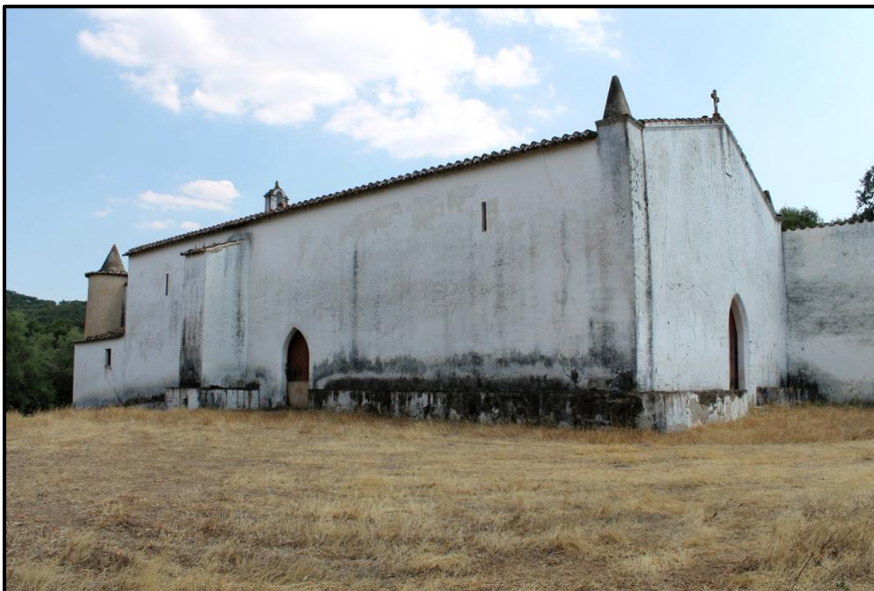
Figura 1- Fachada do Edifício
