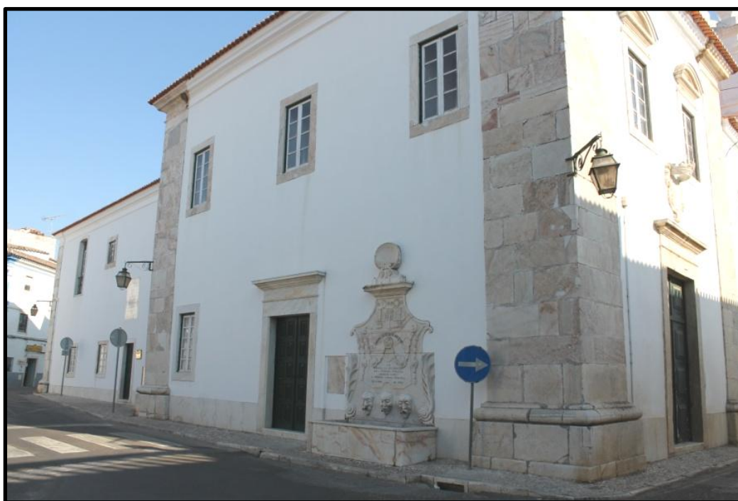
Figura 1- Fachada do Edifício
