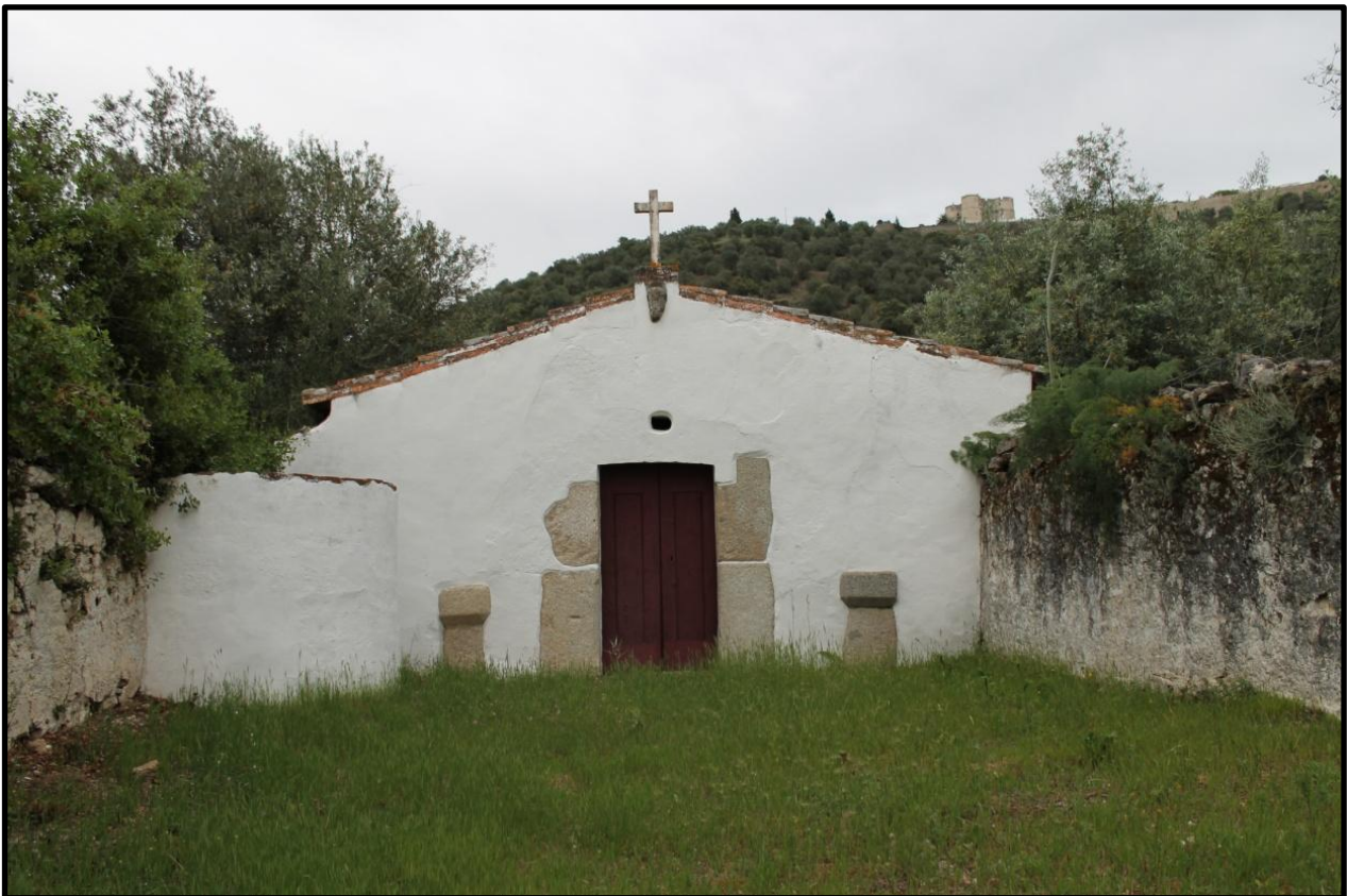
Figura 1- Fachada do Edifício
