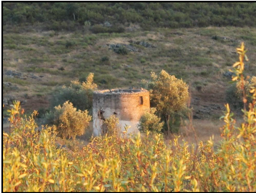
Figura 1- Enquadramento geral do moinho.
