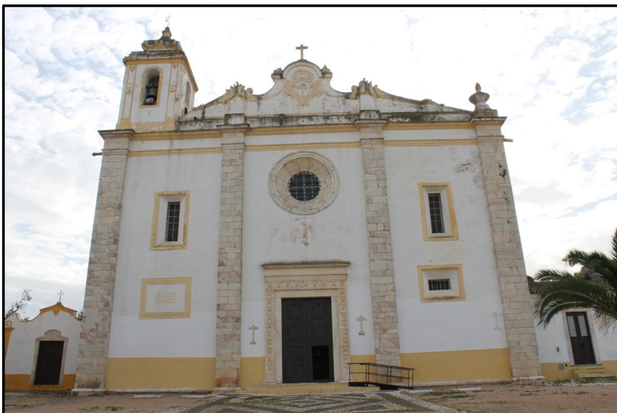
Figura 1- Fachada do Edifício
