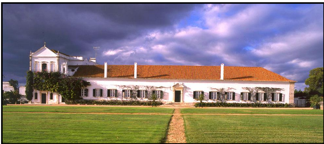
Figura 1- Enquadramento geral do edifício
