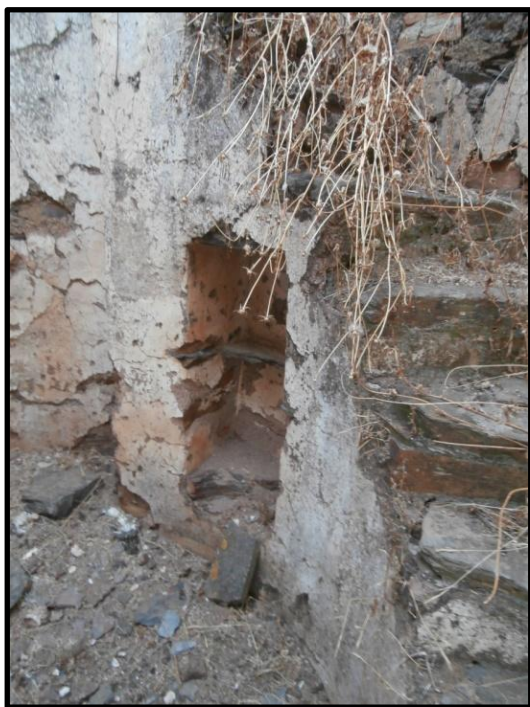
Figura 2- Escada de acesso ao piso superior, e pequeno nicho para arrumação.
