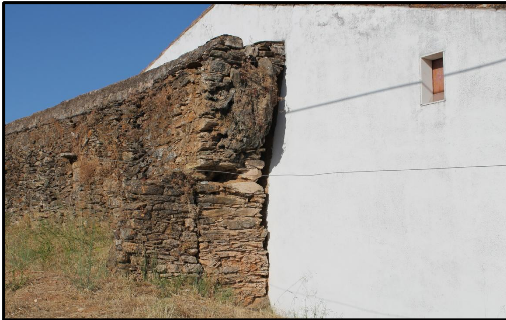
Figura 1- Vestígios do algeroz que conduzia a água até à roda vertical da azenha.
