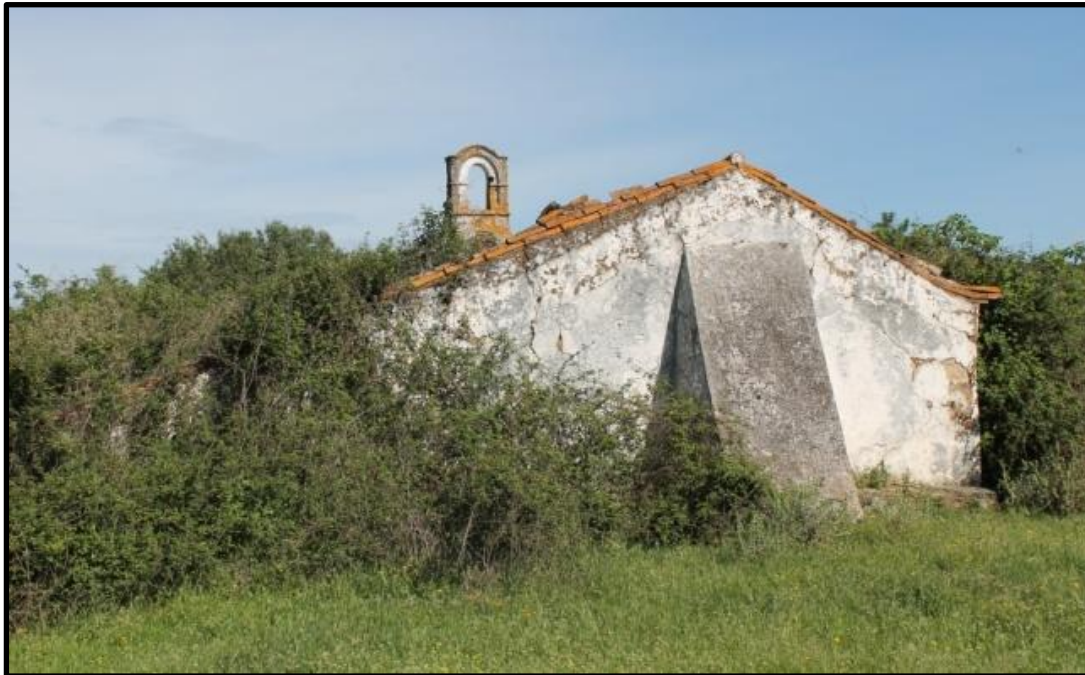
Figura 1- Traseiras da Ermida (contrafortes).
