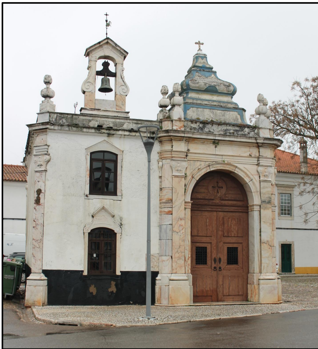
Figura 1- Fachada do Edifício
