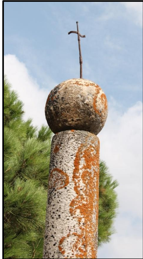
Figura 2- Pormenor dos elementos decorativos
