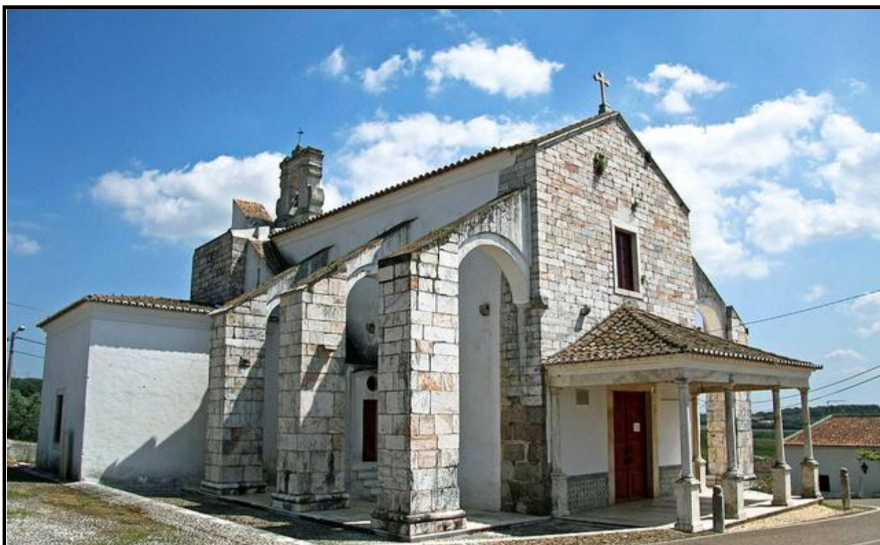
Figura 1- Fachada Principal do Edifício e pormenor do sistema de contrafortagem
