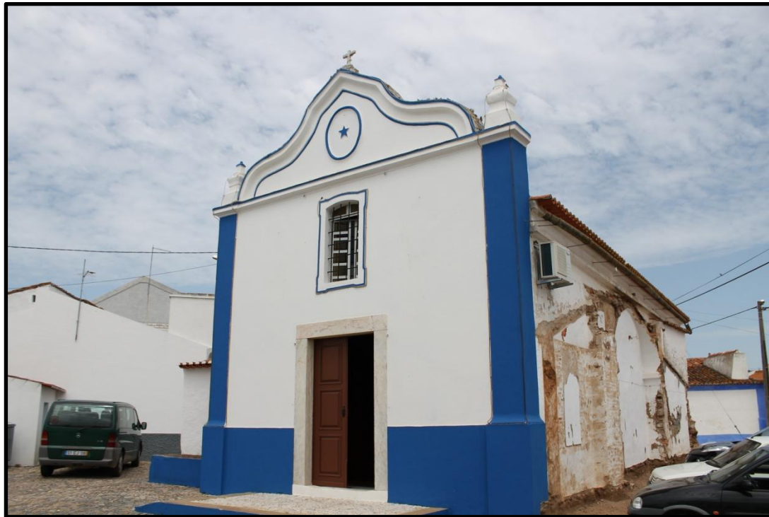
Figura 1- Fachada do Edifício
