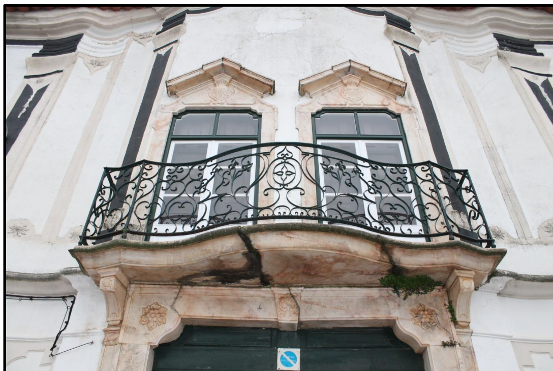
Figura 2- Pormenor das janelas de sacada.
