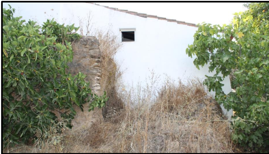
Figura 2- Local onde se encontrava a roda vertical da azenha.
