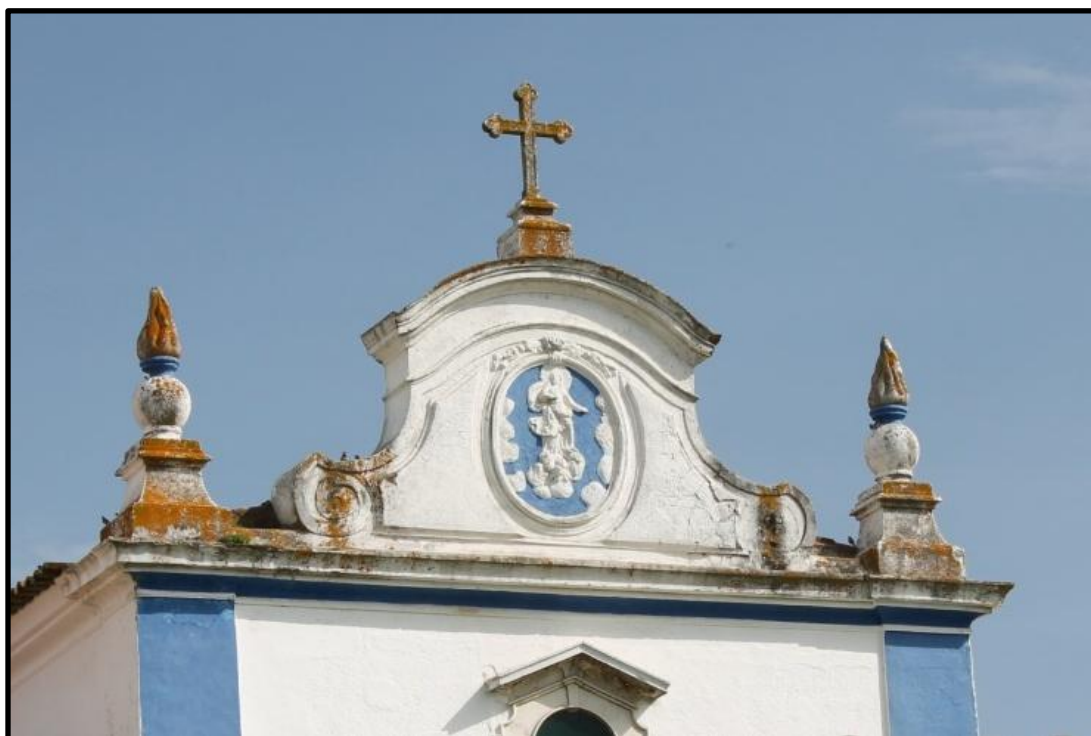
Figura 2- Pormenor da empena do edifício
