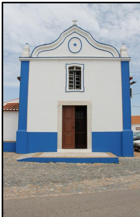
Figura 2 - Vista de frente do edifício
