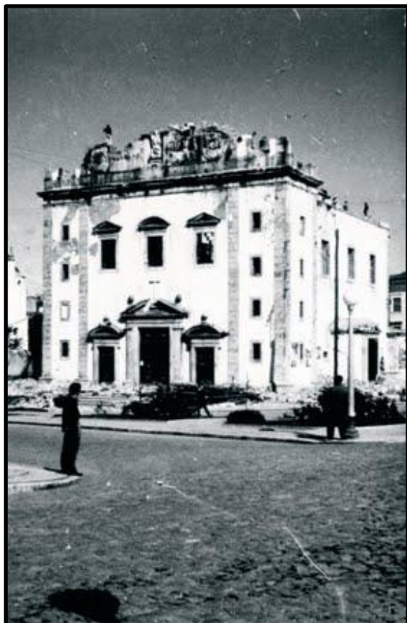
Figura 2- Início da demolição da Igreja
