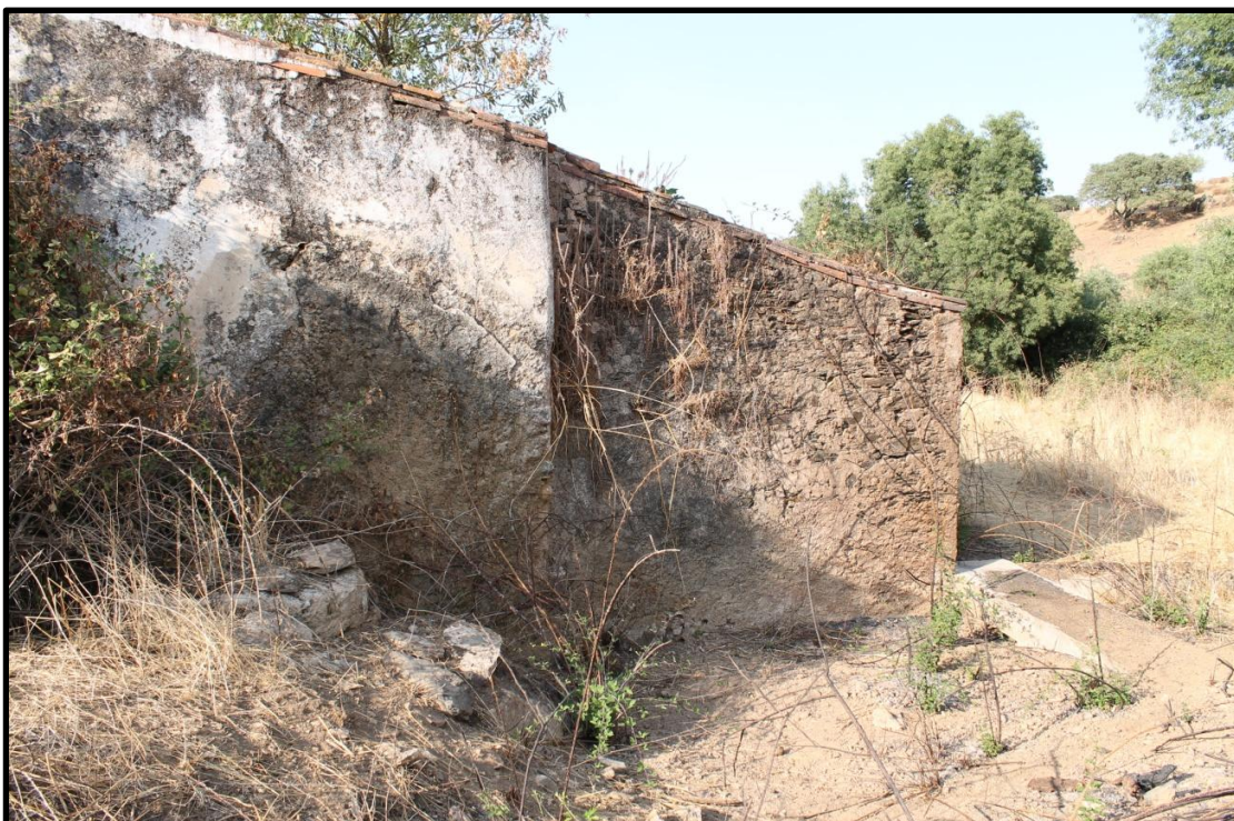
Figura 1- Local onde se encontrava a roda vertical da azenha.
