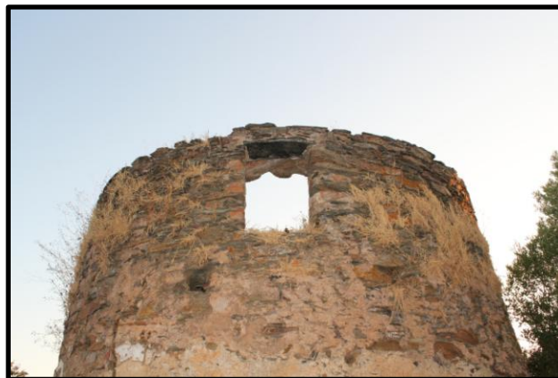
Figura 4- Janela lateral do moinho.
