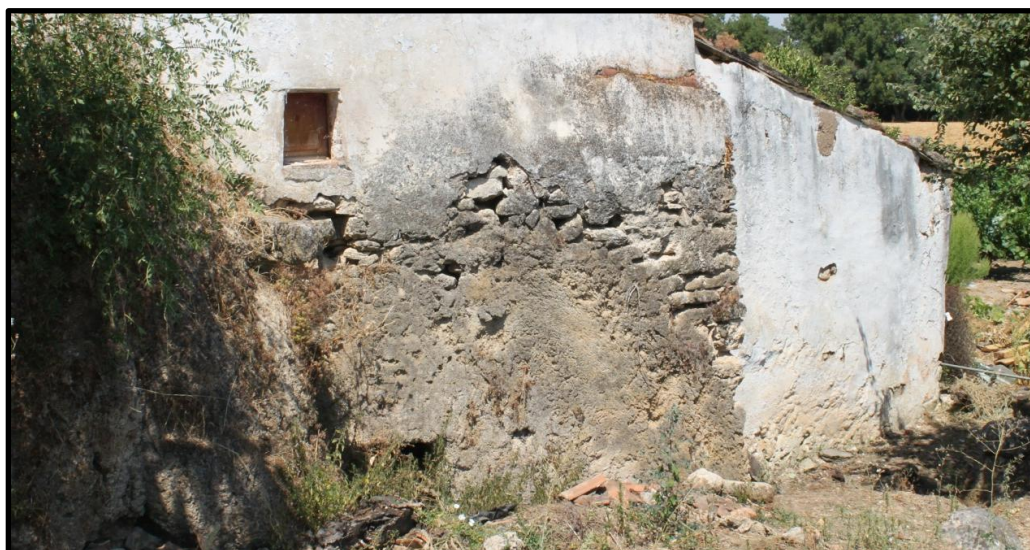
Figura 2- Local onde estaria instalada a roda vertical da azenha.
