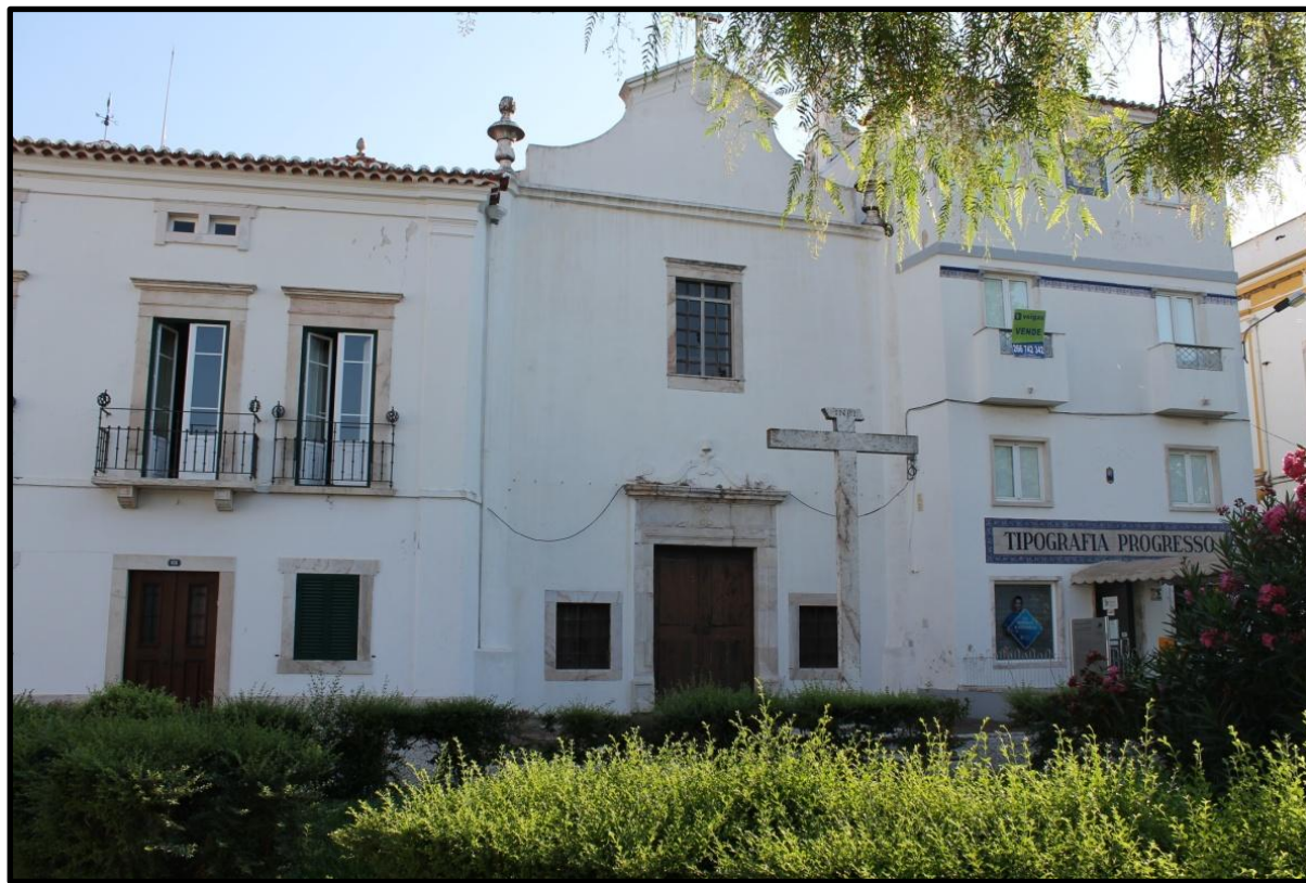
Figura 1- Fachada principal do Edifício
