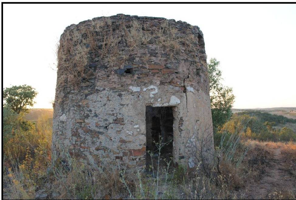
Figura 1- Fachada principal do moinho.
