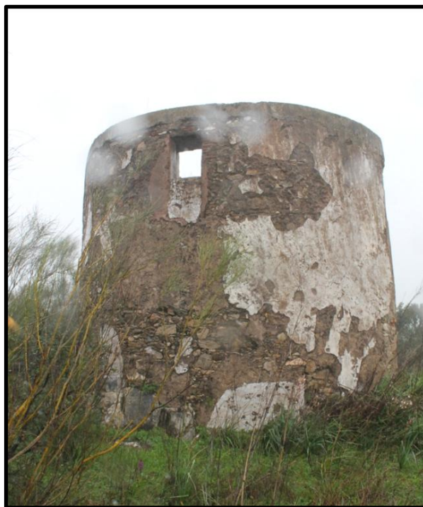
Figura 3- Janela lateral do moinho.
