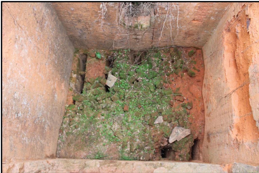
Figura 2- Interior do forno de tijolo
