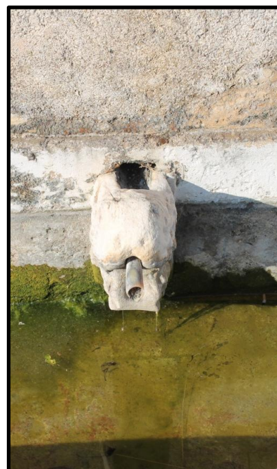
Figura 2 (lado esquerdo) - Vista lateral do chafariz
