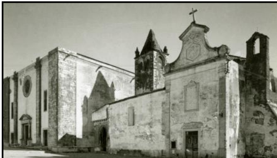
Figura 1- Edifício antes de entrar em ruína
