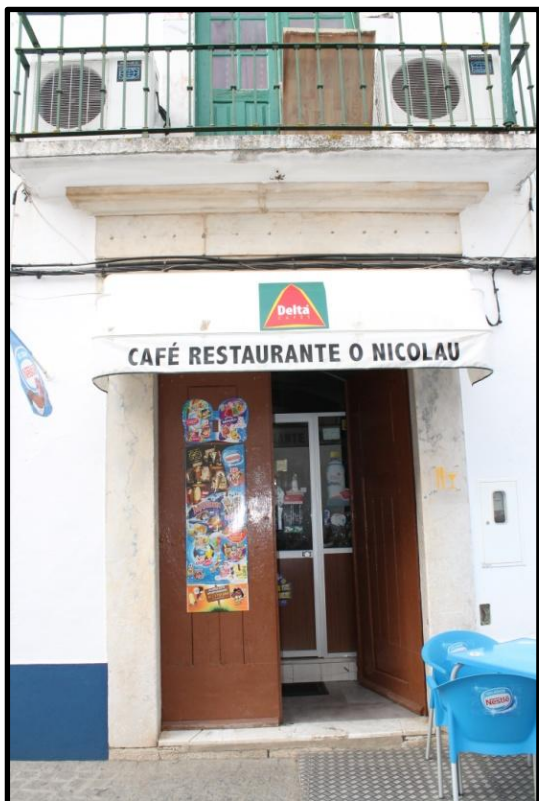
Figura 1- Fachada do Edifício, pórtico de entrada
