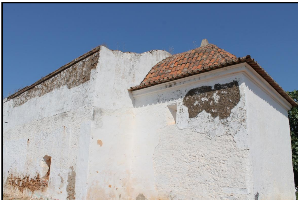
Figura 2- Pormenor da cúpula da capela-mor
