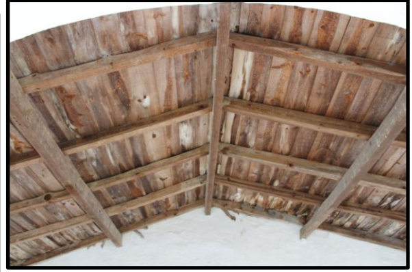
Figura 3 - Alpendre da Ermida, em cima pormenor do teto em madeira
