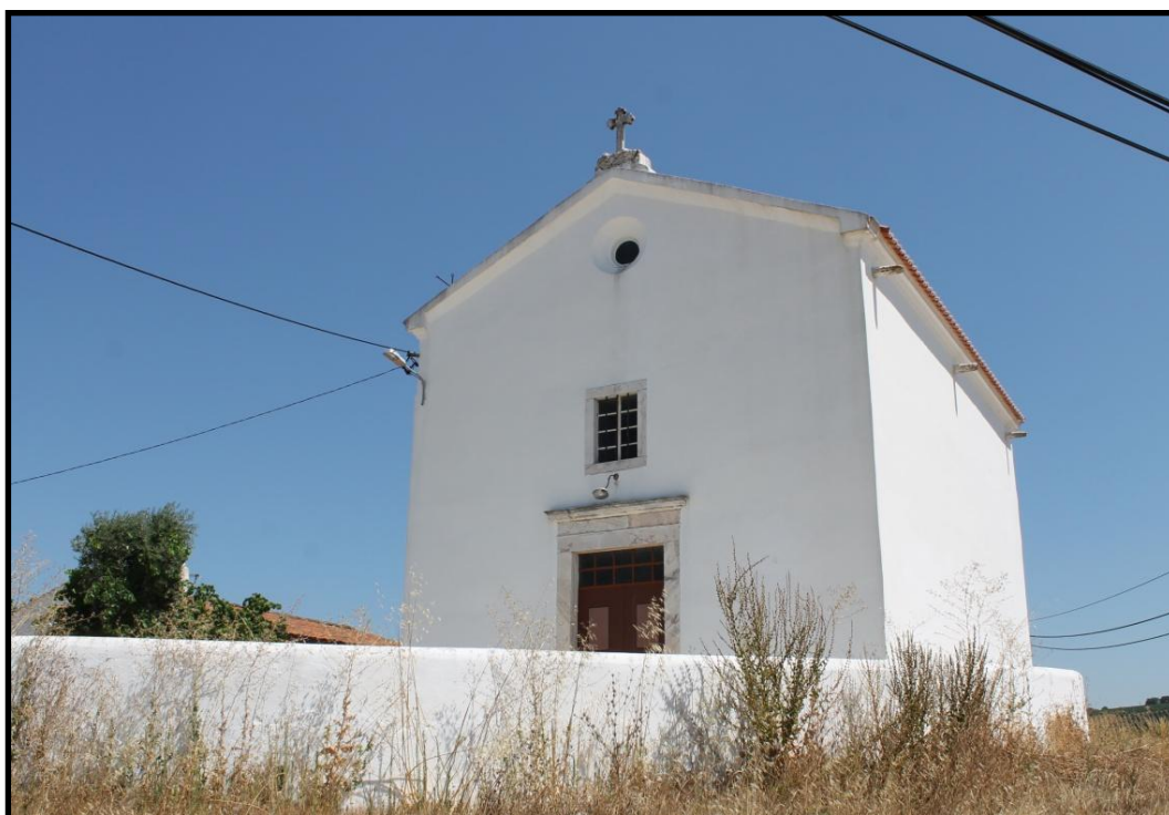
Figura 1- Fachada principal da Ermida
