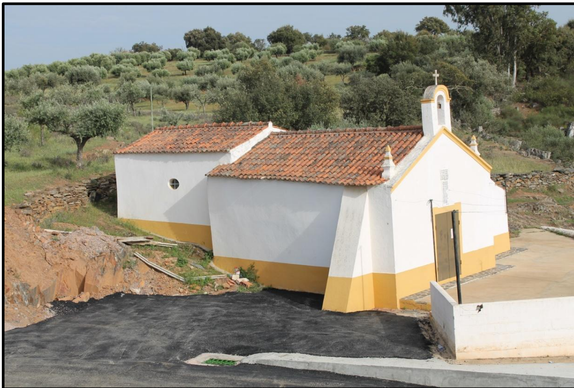
Figura 1- Fachada do Edifício
