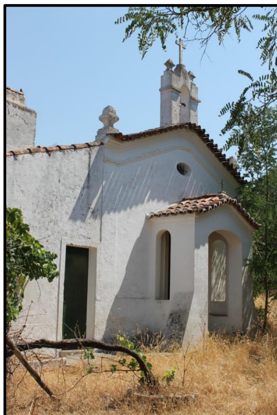
Figura 2- Pormenor da fachada principal
