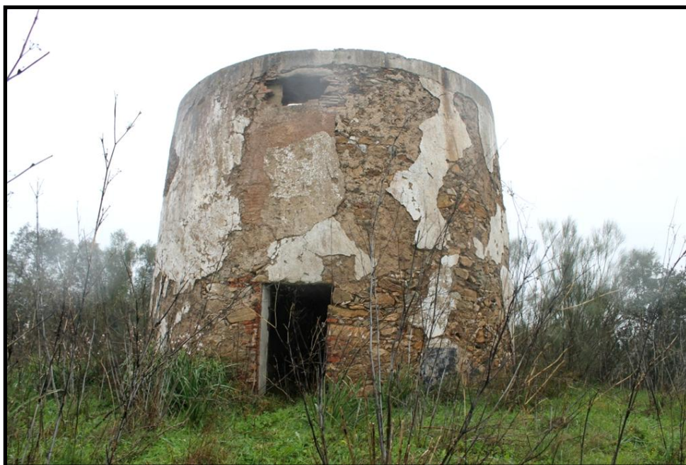
Figura 1- Fachada principal do moinho.
