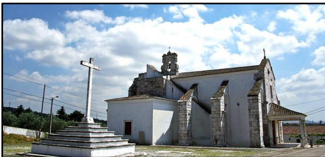
Figura 4- Vista geral do edifício
