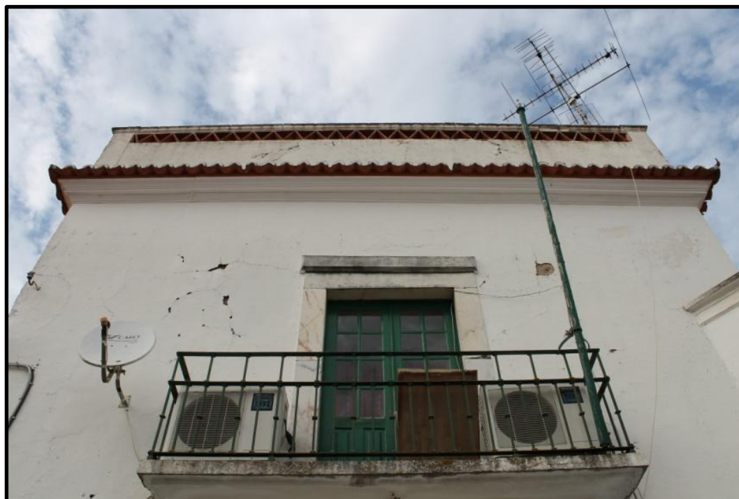
Figura 3- Pormenor do balcão de sacada
