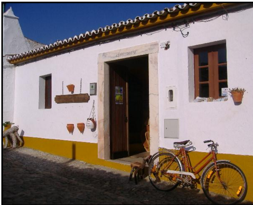
Figura1- Celeiro Comum de Evoramonte: enquadramento geral
