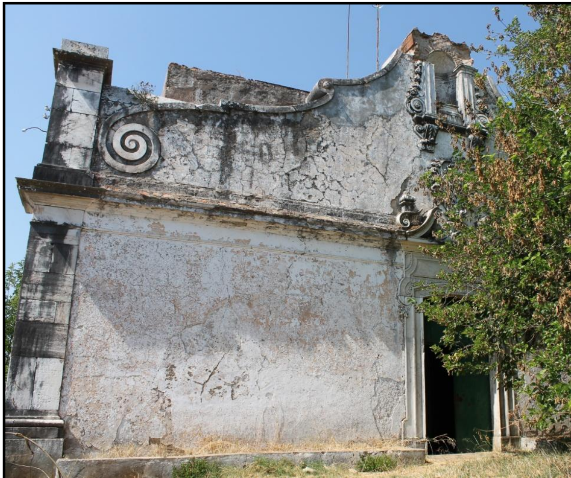
Figura1- Fachada do edifício
