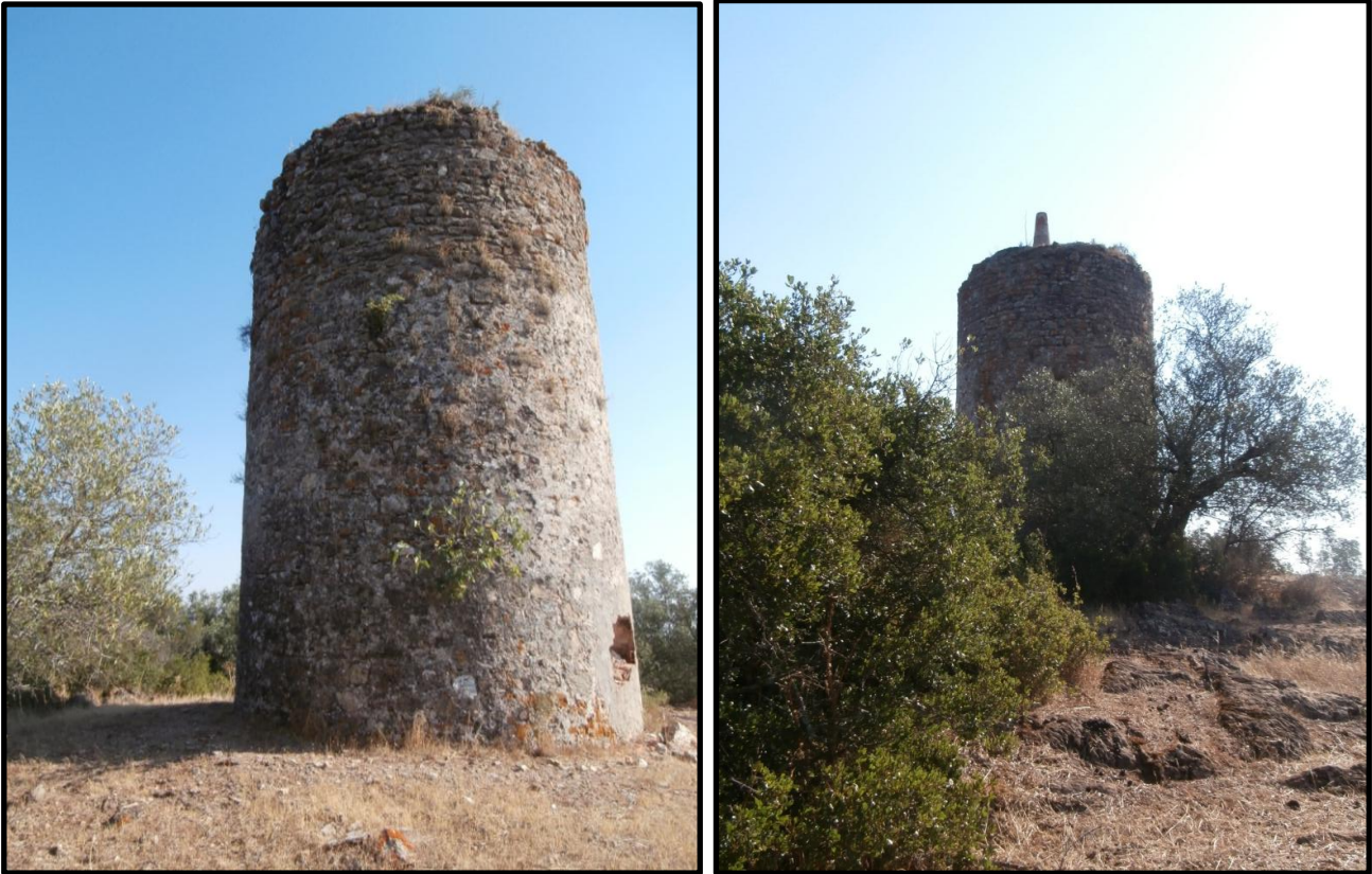
Figura 1 e 2- Atalaia das Casas Novas: enquadramento geral
