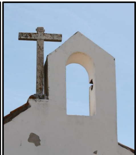
Figura 3- Campanário e cruz de remate fachada do Edifício
