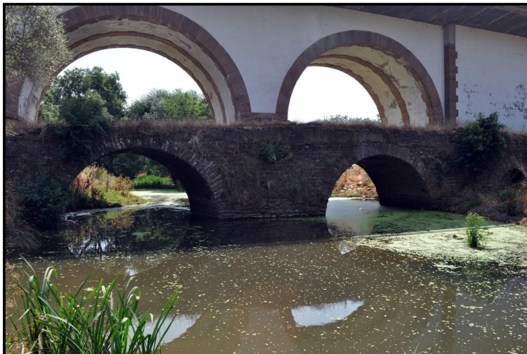
Figura 1- Ponte de Veiros: vista a jusante
