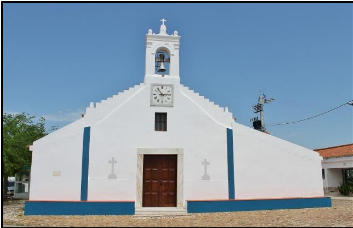
Figura 1- Fachada do Edifício
