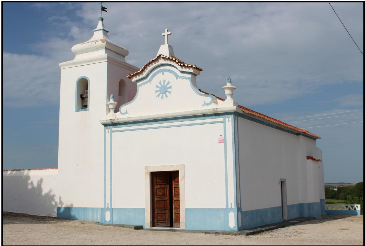
Figura 1- Fachada do Edifício
