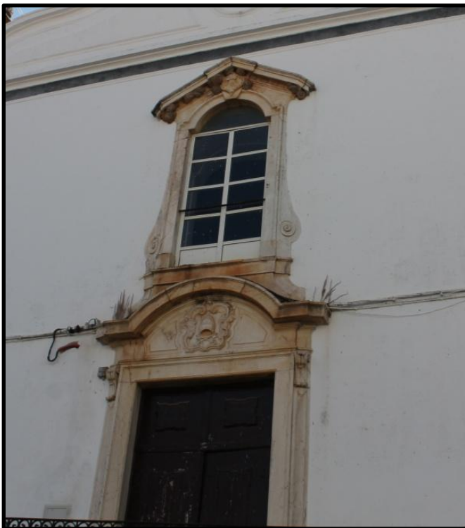
Figura 2- Pormenor do janelão e da portada em mármore
