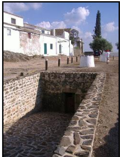
Figura 2- Entrada da cisterna
