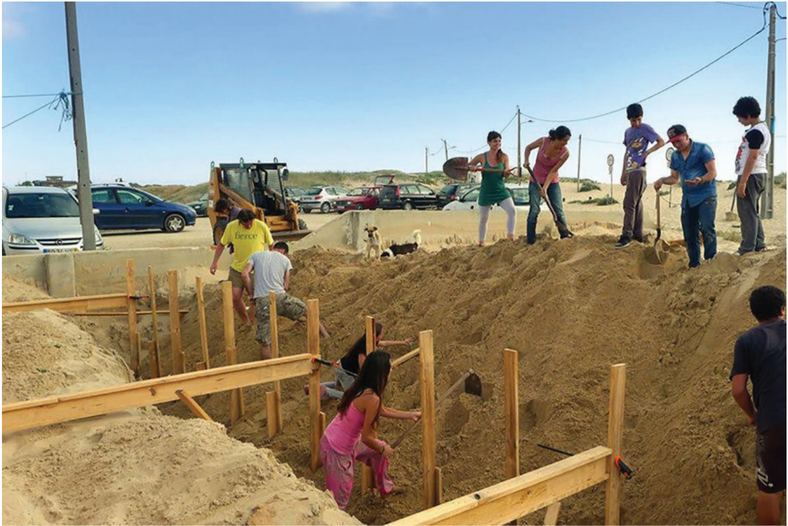
Casa do Vapor, construção, 2013.
