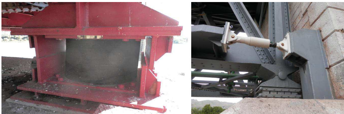
a) Aparelho de apoio HDRB
