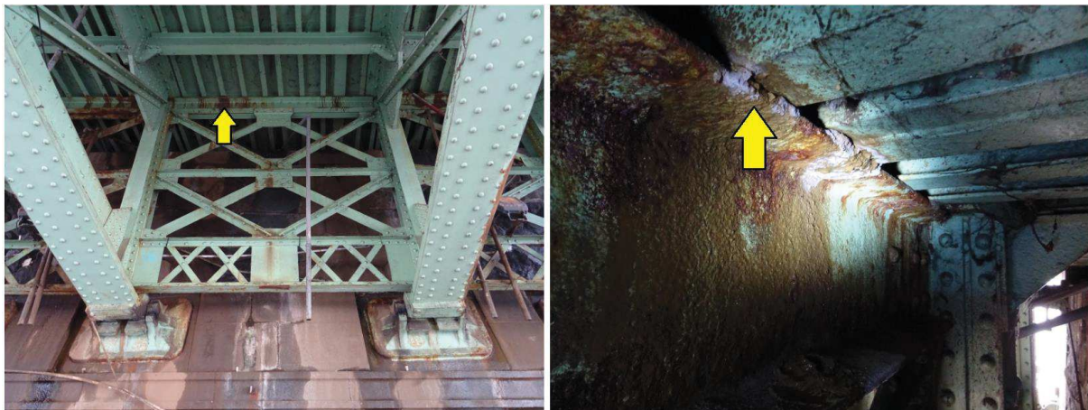
a) Vista geral da estrutura metálica
