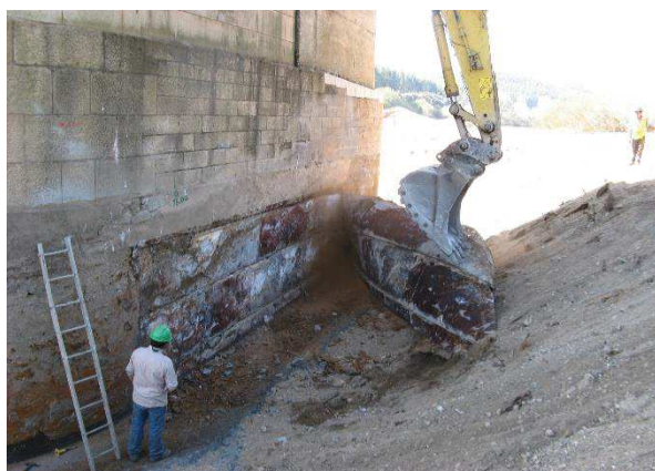
a) Remoção das chapas de proteção
