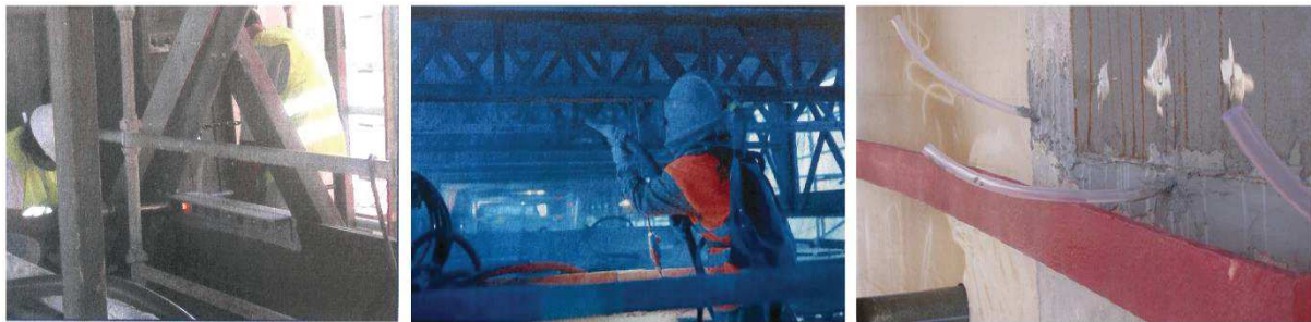
a) Reforço da viga treliçada
