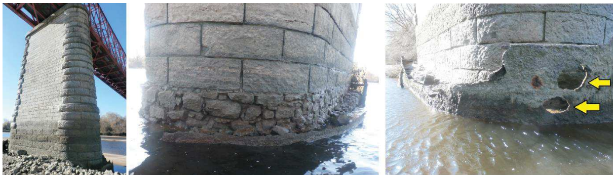
a) Vista do pilar
