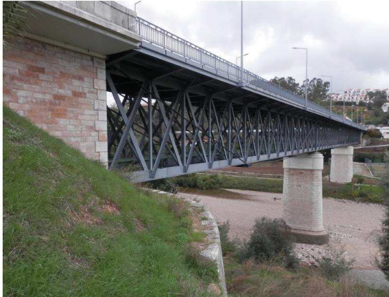
a) Ponte de Constância s/ rio Zêzere
