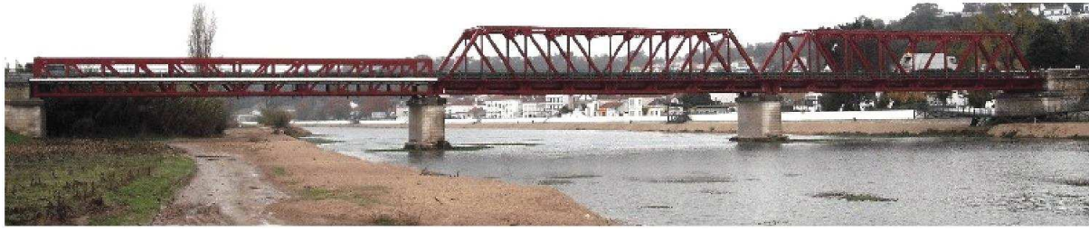
a) Ponte General Teófilo Trindade s/ o rio Sorraia
