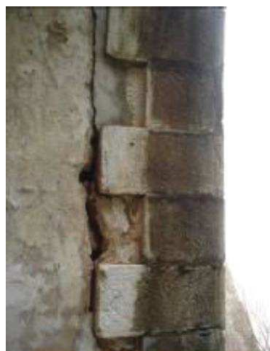
a) Fenda vertical no paramento [26]
