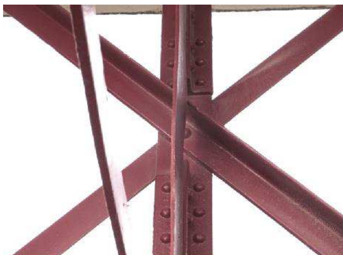
a) Deformação de encurvadura por compressão
