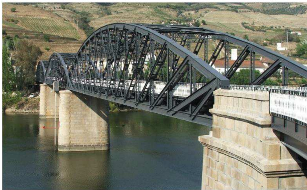
a) Ponte s/ o rio Douro na EN323
