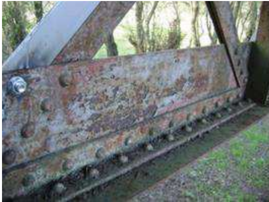
a) Corda inferior de viga treliçada [13]
