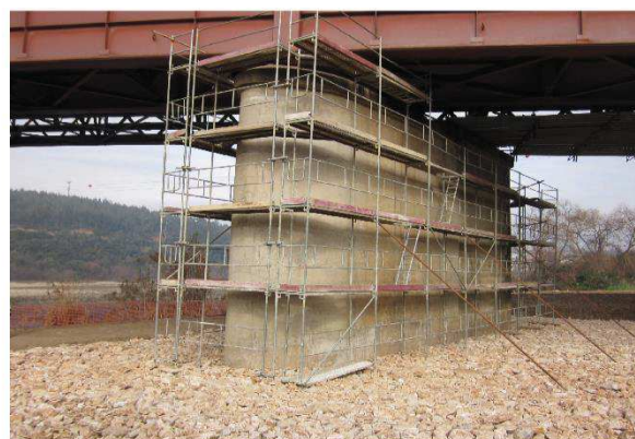
d) Reparação de pilar
