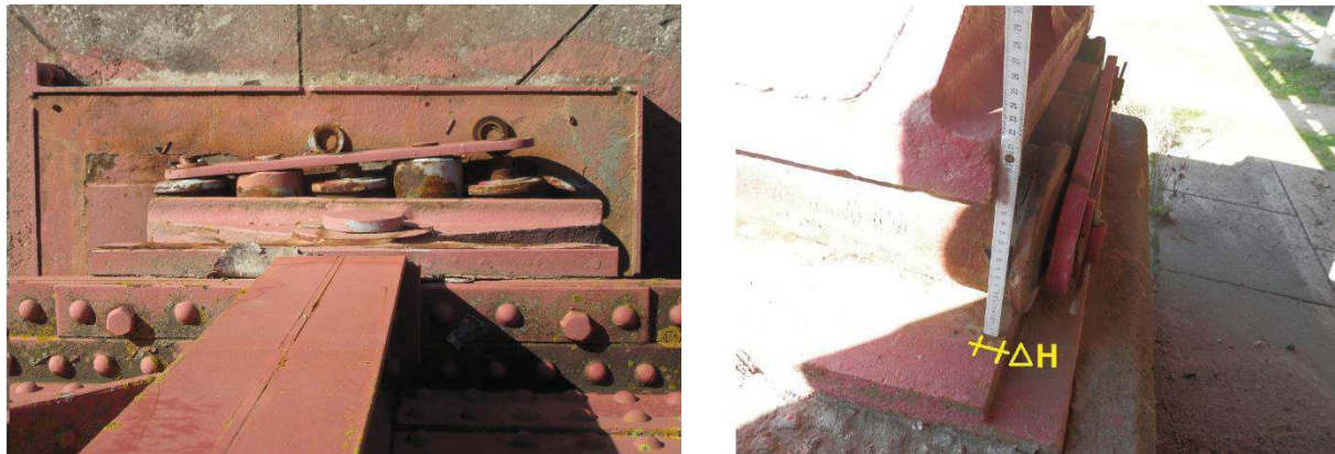
Figura 3.17 – Forças residuais que provocam desalinhamentos entre o tabuleiro e os aparelhos de apoio
