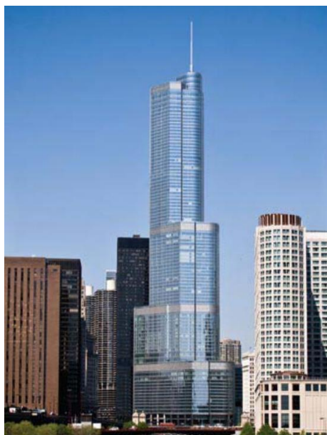
Figura 3.4 – Trump Tower em Chicago, com 423 m de altura [55].
