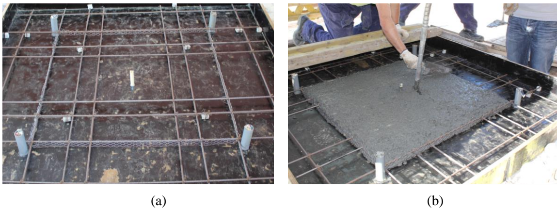
Figura 5.6 – Rede hexagonal usada como molde da zona em BER (a) e betonagem localizada de BER (b).
