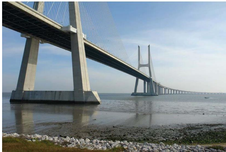
Figura 3.6 – Ponte Vasco da Gama [53].
