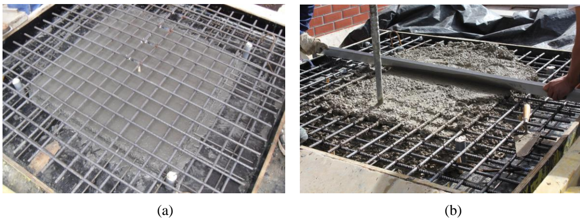
Figura 5.7 – Vista geral após betonagem da zona em BER (a) e durante a betonagem com betão normal (b).
