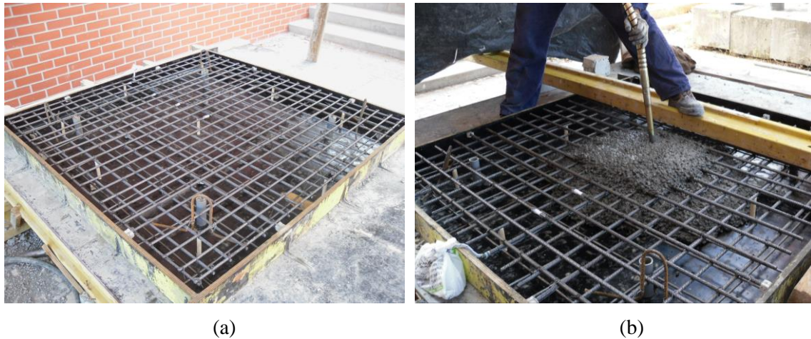
Figura 4.3 – Vista geral do molde e armadura (a) e betonagem (b).
