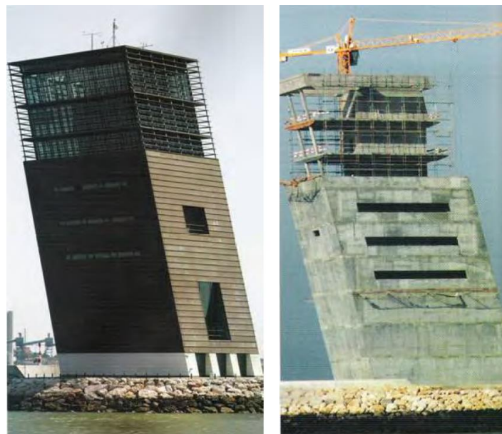
Figura 3.7 – Edifício do Centro de Coordenação e Controlo de Tráfego do Porto de Lisboa
