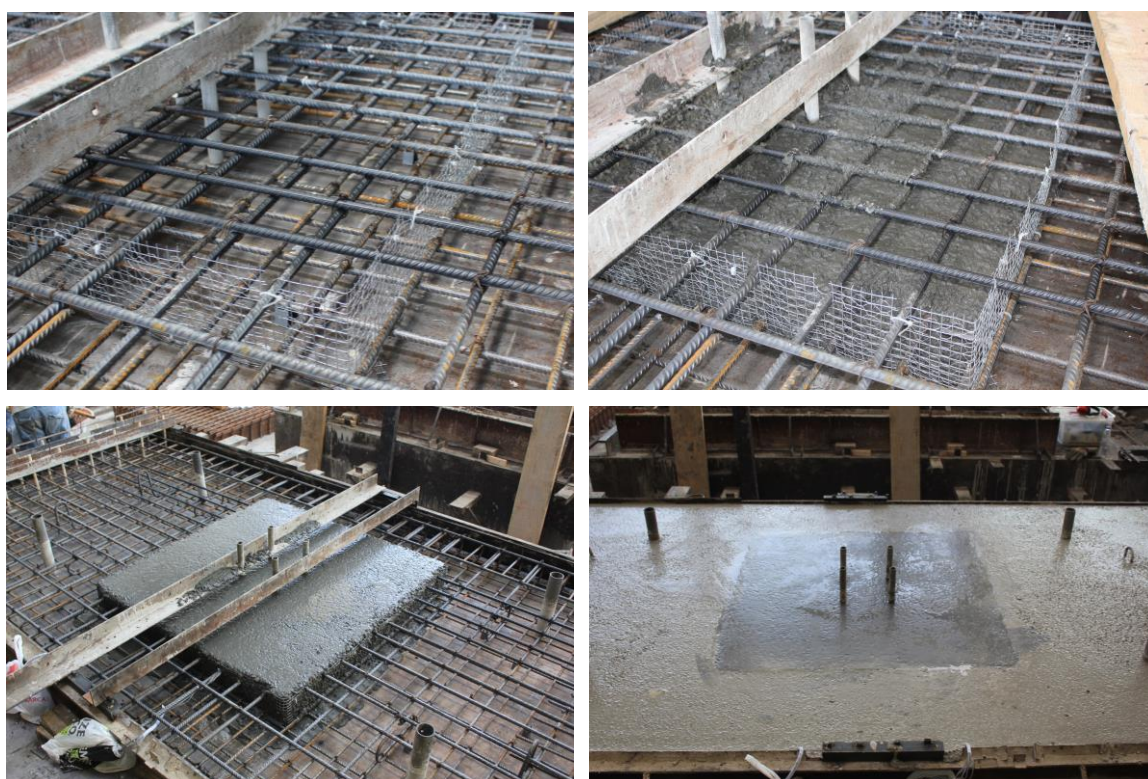
Figura 7.5 – Fotos da betonagem do modelo CSHC2.
