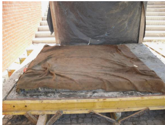
Figura 4.4 – Laje após betonagem, coberta com manta de serapilheira humedecida.
