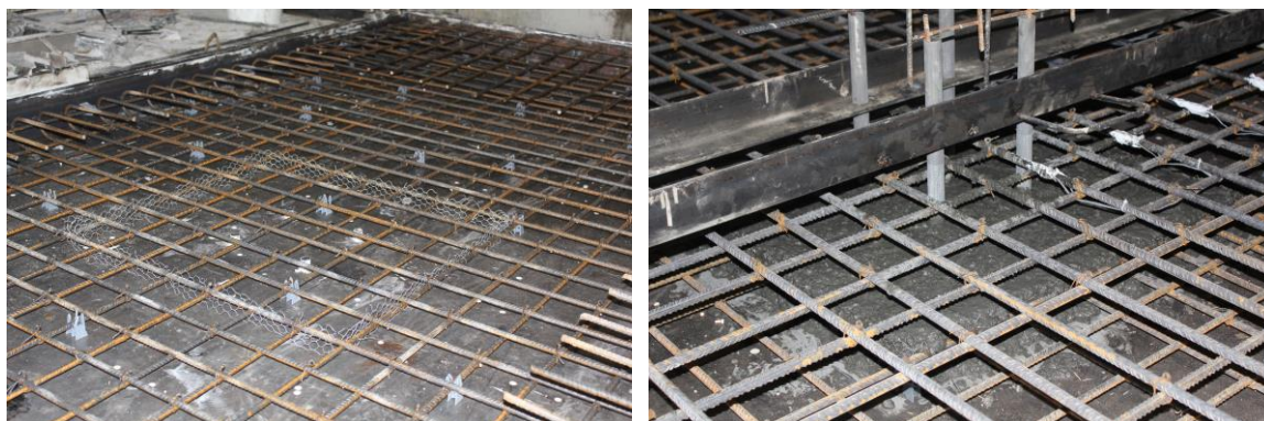
Figura 7.4 – Fotos da betonagem do modelo CHSC1.
