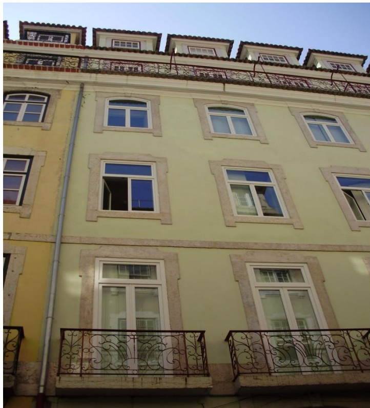
Figura 4.1 - Edifício da Rua Nova do Carvalho (Appleton & Domingos, 2009).
