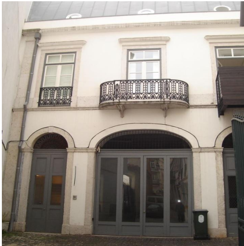
Figura 4.5 - Edifício da Travessa do Forno
