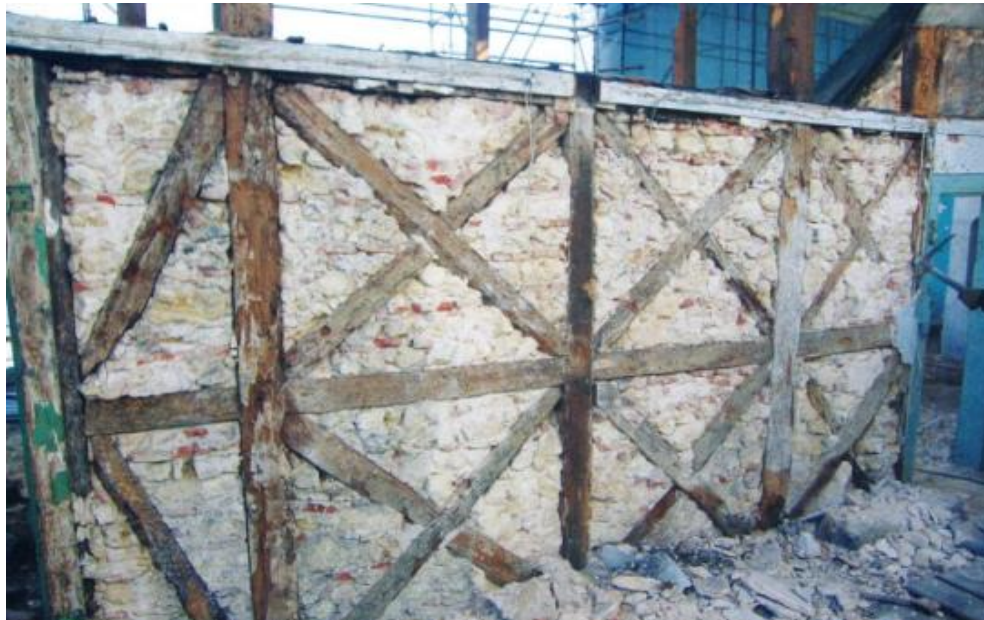
Figura 2.19 – Parede de frontal após remoção de reboco (Appleton & Domingos, 2009).
