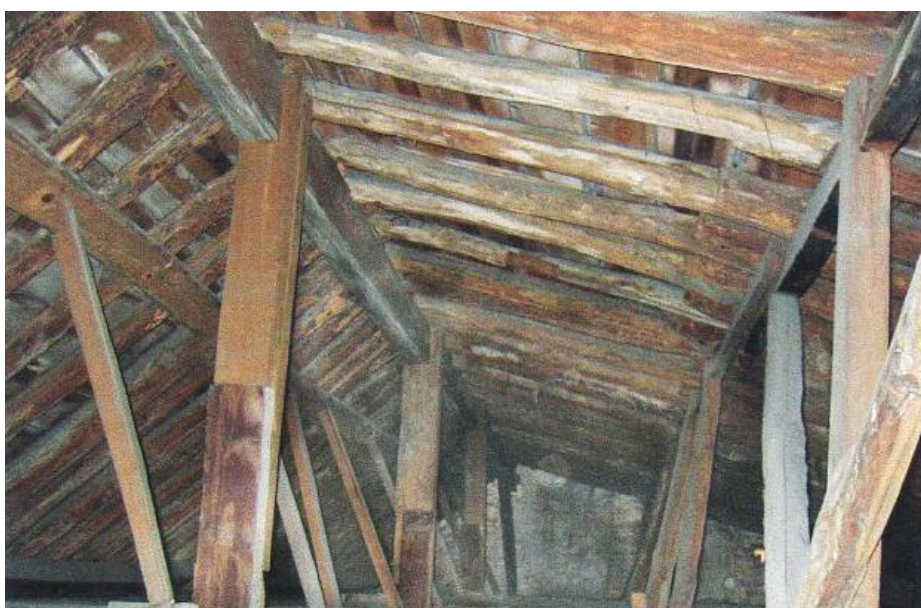
Figura 2.27 - Cobertura do edifício da Rua Nova do Carvalho (Appleton & Domingos, 2009).
