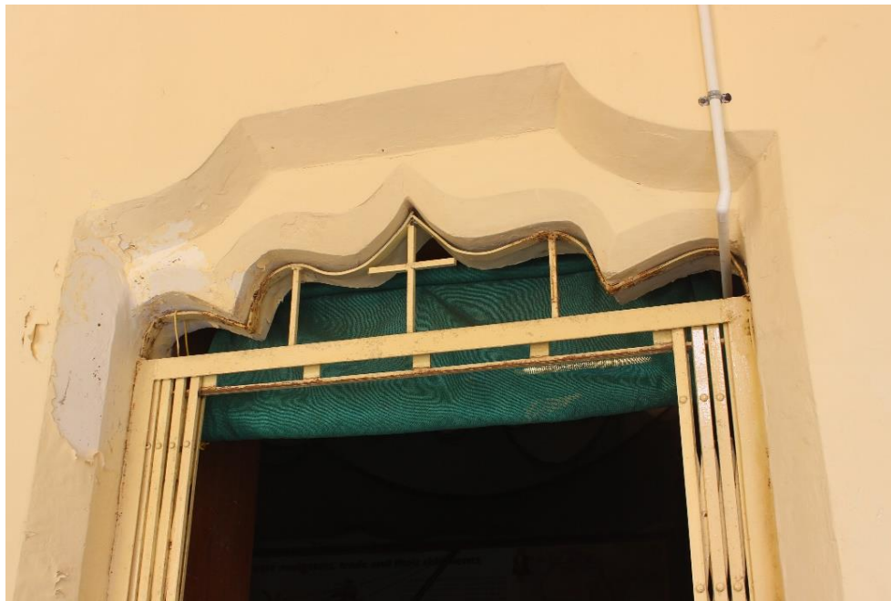
Fig. 12 - Convento de São Francisco, Velha Goa, Índia. Lintel manuelino (Janeiro de 2019)
