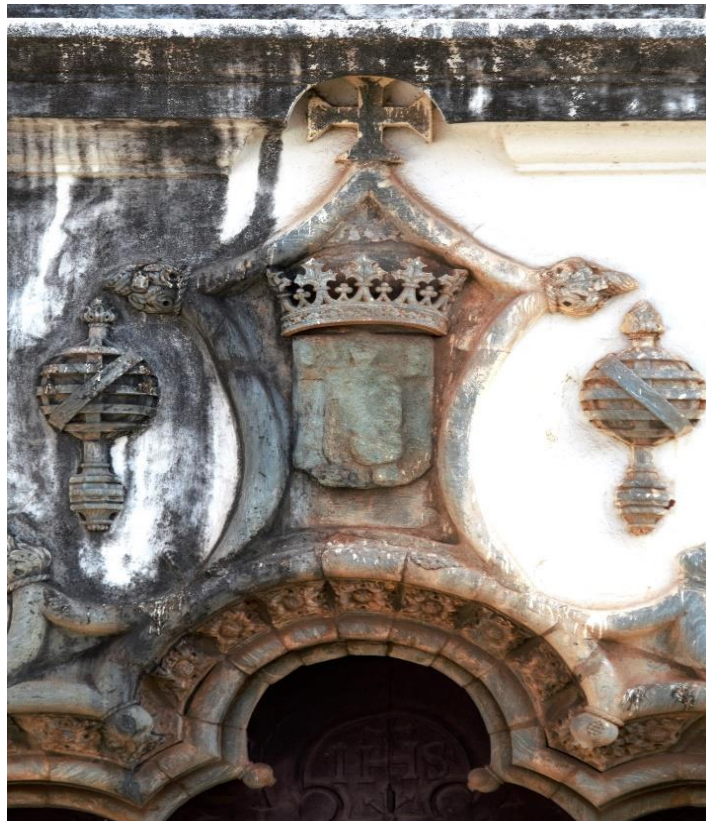
Fig. 17 - Igreja do Espírito Santo, Velha Goa, Índia. Detalhes do portal central (Janeiro de 2019)
