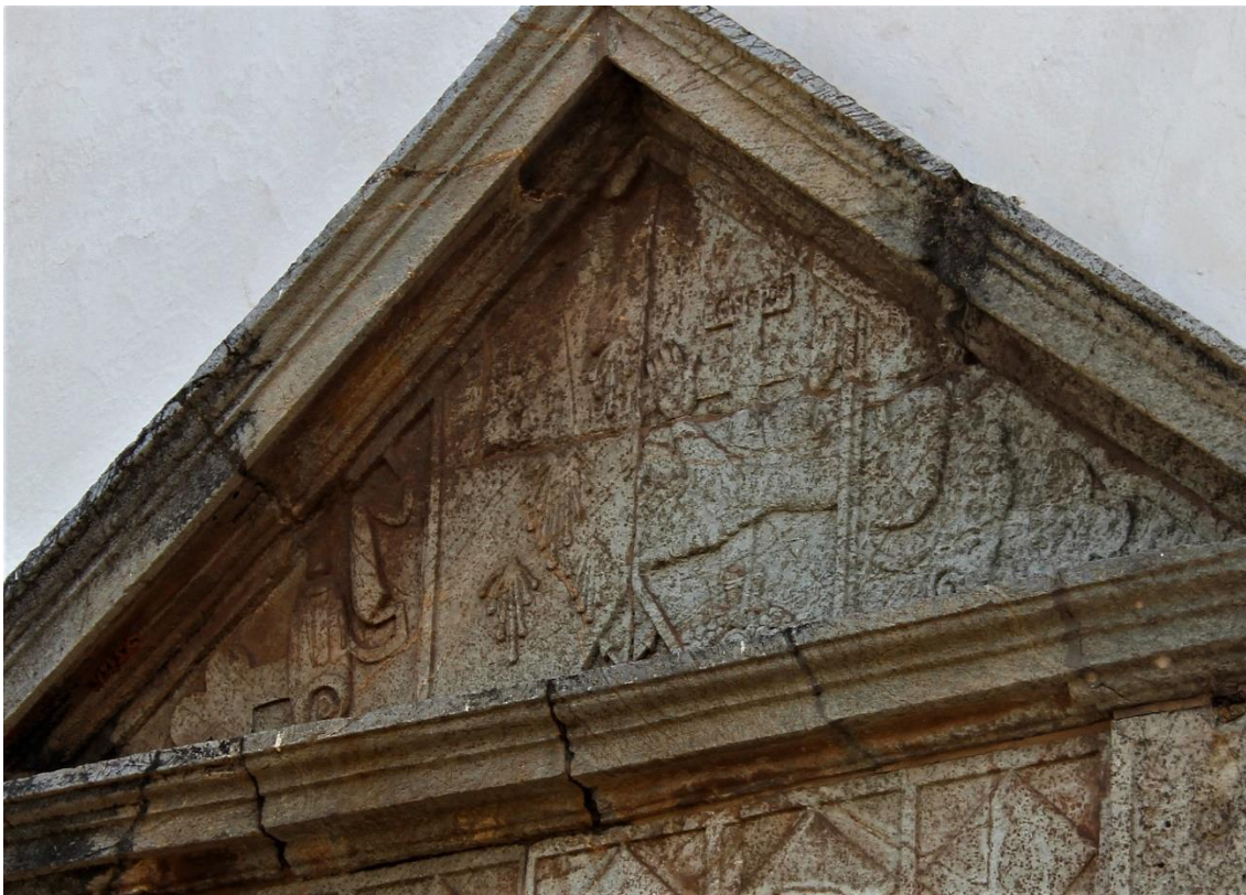
Fig. 82 - Igreja do Espírito Santo, Velha Goa, Índia. Frontão do portal lateral sul (Janeiro de 2019)
