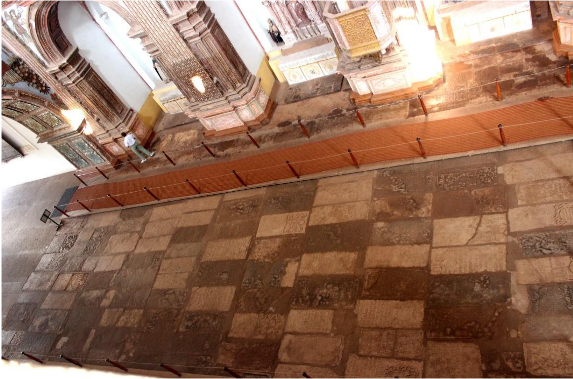
Fig. 7 - Igreja do Espírito Santo, Velha Goa, Índia. Vista sobre o pavimento (Janeiro de 2019)
