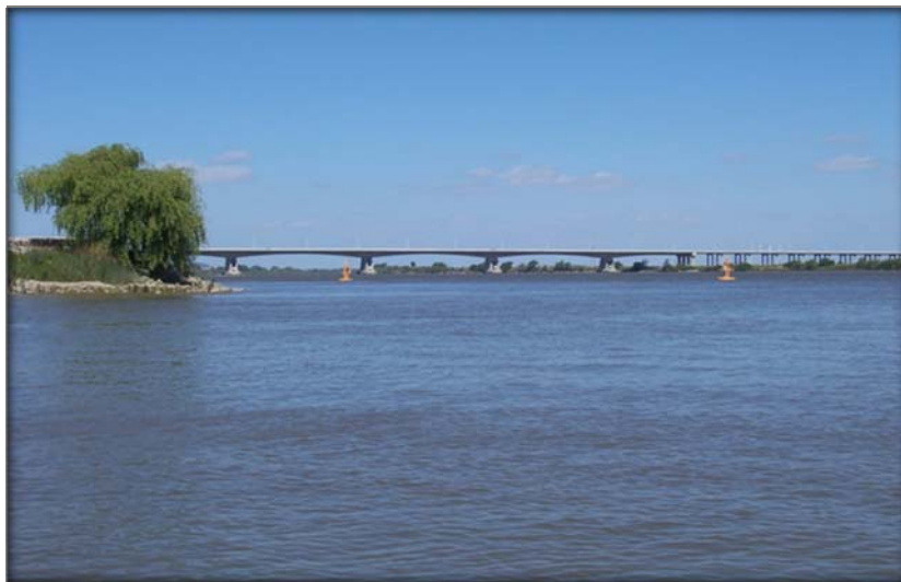
Ilustração 7. Ponte da Lezíria - Rio Tejo na Vala do Carregado
