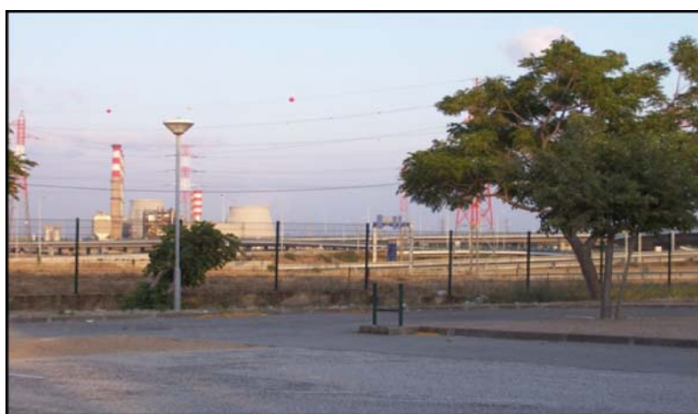
Ilustração 8. Central Termoeléctrica do Carregado 32
