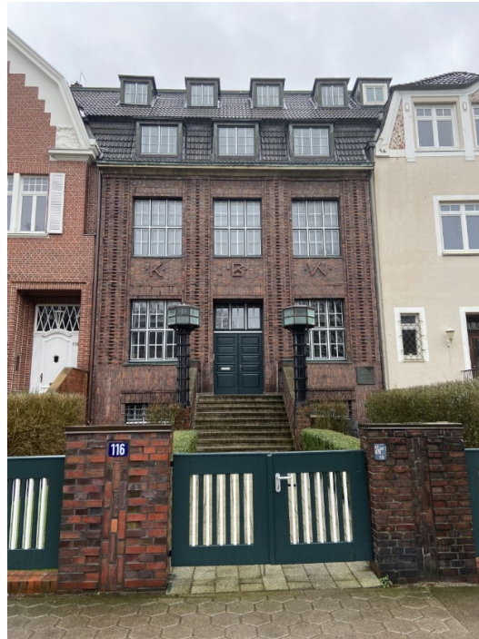
Fachada da Kulturwissenschaftliche Bibliothek Warburg, em Hamburgo. Sobre a fachada, em alto relevo, as iniciais KBW. Fotografia de fevereiro de 2020. © Acervo pessoal da autora
