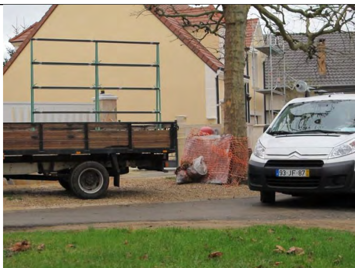
Figura 9 Trabalhadores Portugueses na construção civil- Vale de Marne, França (2011)
