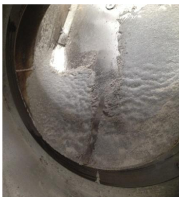
Figura 6.18 – Humidade presente no interior da parede de escoamento da Peletizadora
