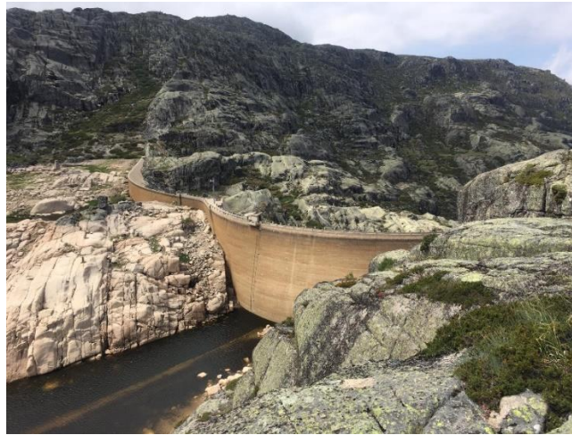
a) Vista do paramento de montante
