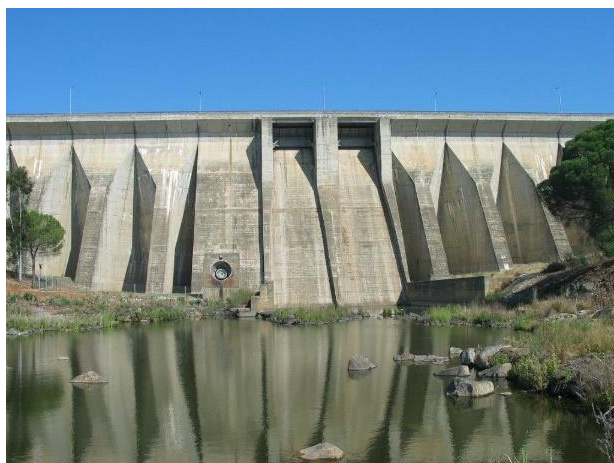
Figura 2.3 - Vista de jusante da zona em betão da barragem do Caia - estrutura de contrafortes
