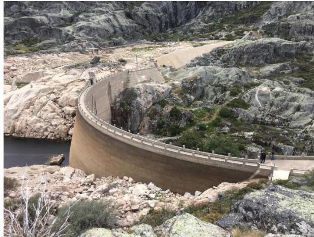
Figura 2.11 - Passagem pedonal do coroamento da barragem de Covão do Meio
