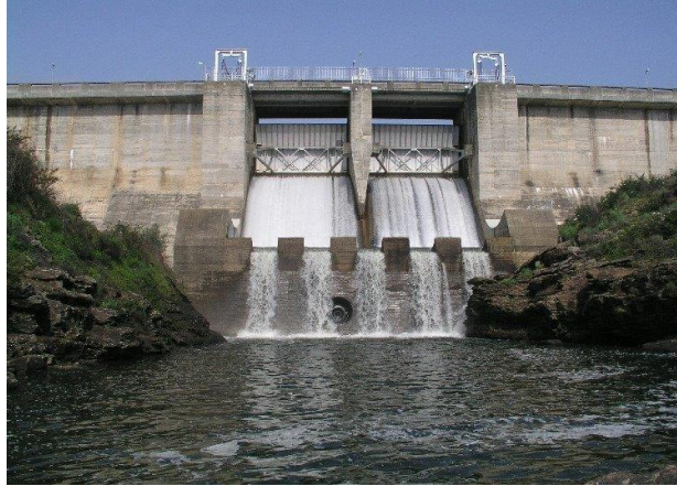
Figura 2.1 - Vista de jusante da barragem do Monte Novo - barragem gravidade
