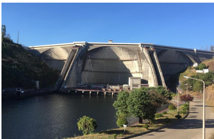
Figura 2.19 - Vista do paramento de jusante da barragem da Aguieira
