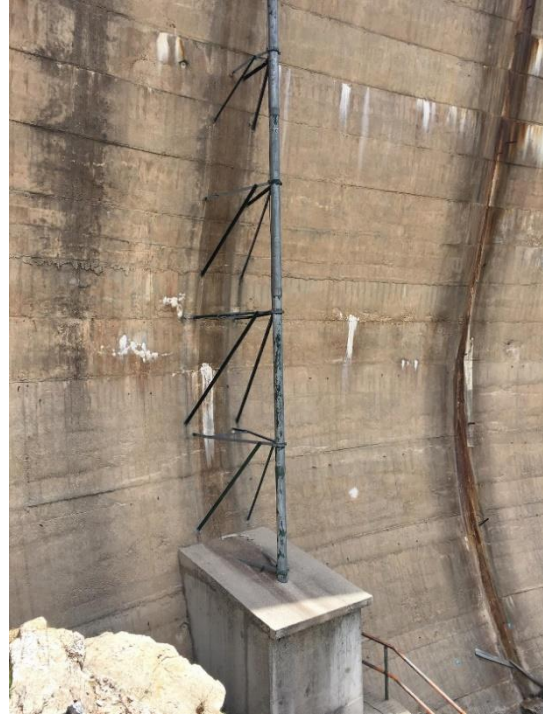
b) Frio de prumo invertido (local de medição dos deslocamentos horizontais próximo da base da barragem)
