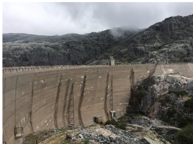
b) Vista do paramento de jusante
