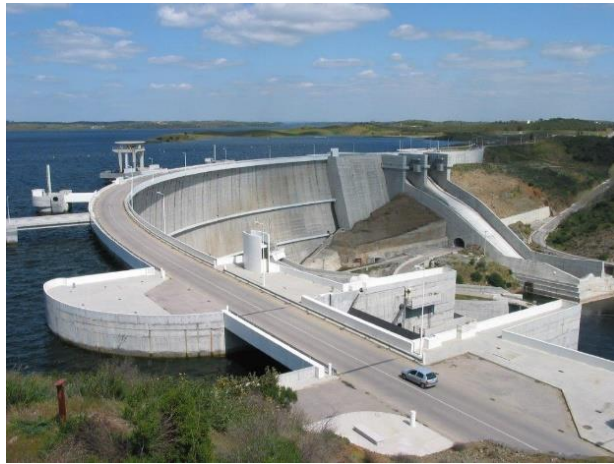
Figura 2.2 - Vista do lado da margem direita da barragem de Alqueva - barragem abóbada
