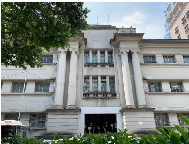
Figura 8 O Edifício do Antigo Tribunal (ref. o autor)
