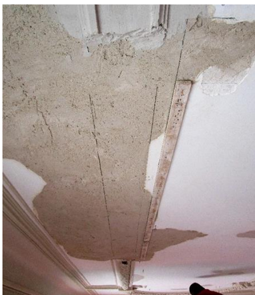
Figura 5.4 - Marcação e pregagem de ripas de madeira (técnica de apenas uma ripa)
