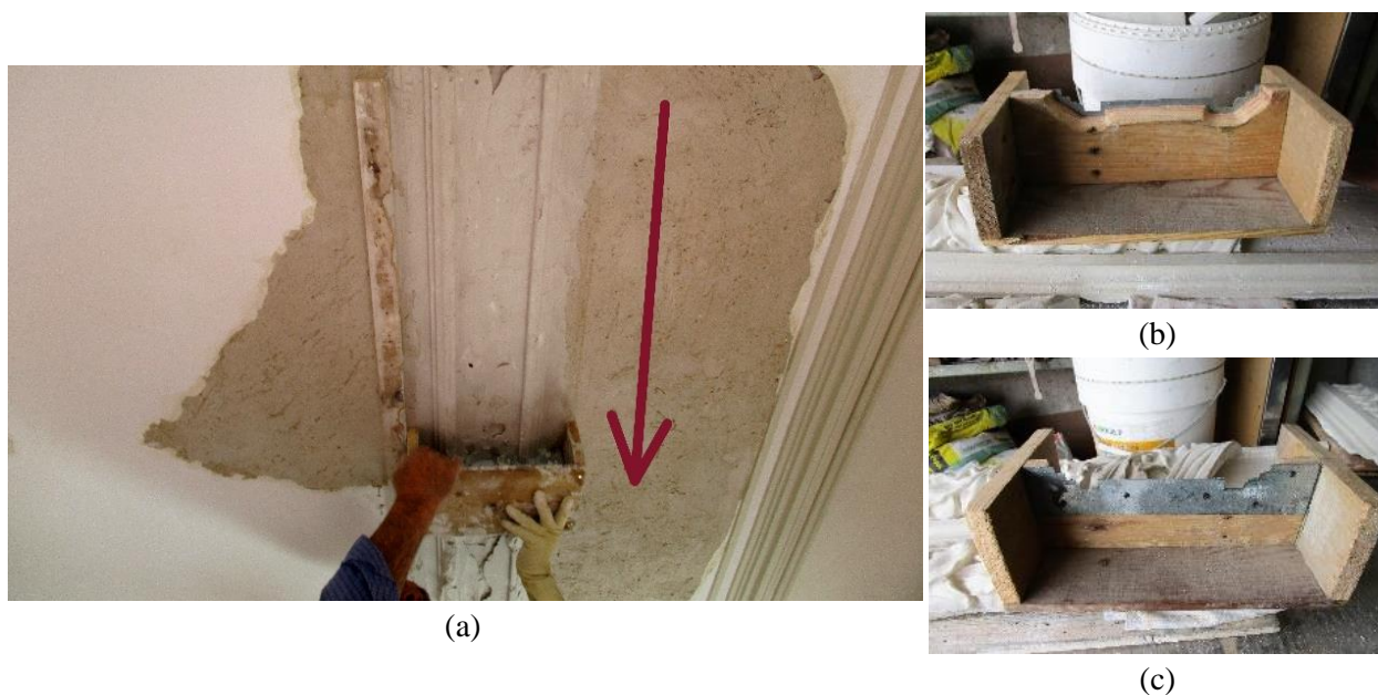
Figura 5.6 - Execução de elementos moldados corridos in situ : (a) moldura recta; (b) molde na posição de moldar; (c) molde na posição de cortar.
