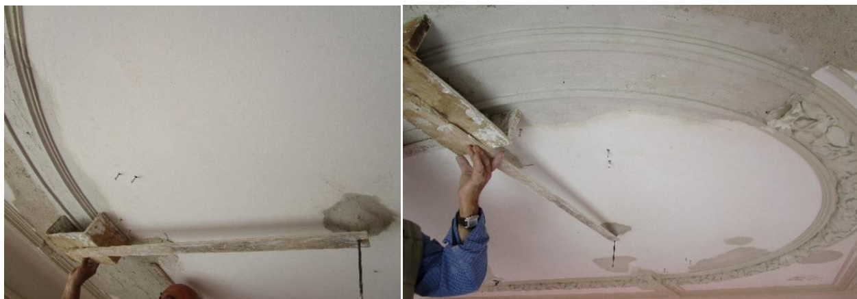
Figura 5.5 - Execução de uma moldura redonda pela técnica da moldagem in situ
