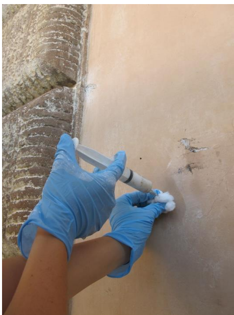
Figura 2.4 – Consolidação do revestimento exterior na Biblioteca Hertziana Palazzo Zuccari em Roma.[34]
