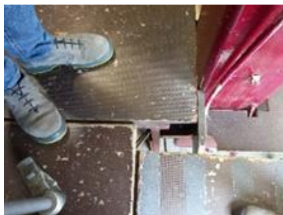
Figura 3.14. Cavidade na plataforma de trabalho
