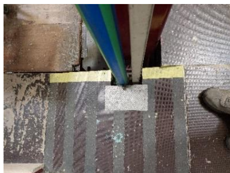
Figura 3.26. Cavidade da plataforma reparada
