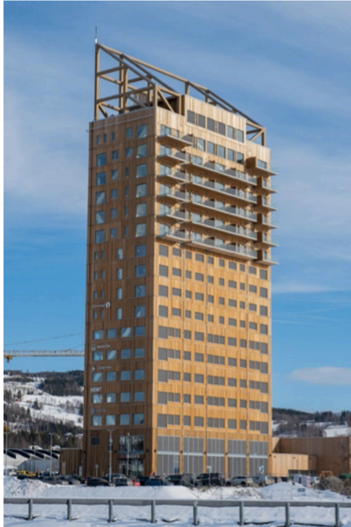
Figura 3.7: Mjøstårnet building, Noruega [19]
