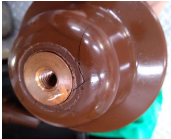
Figura 5.22-Aspetto exterior da travessia, após o ensaio do impulso.
