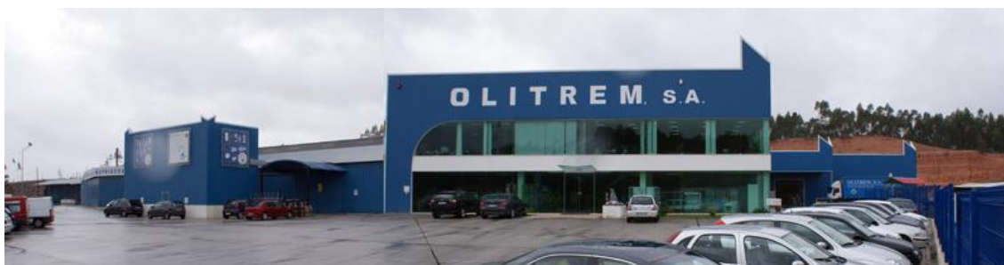
Figura 6.1: Fachada Principal da Empresa em Tremês – Santarém. Fonte: (Olitrem S.A., 2009)
