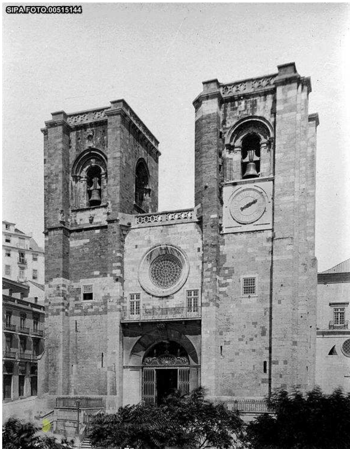
Figura 1: Fachada principal, antes das obras de restauro de 1900. (in http://www.monumentos.pt/Site/APP_PagesUser/SIPAArchives.aspx?id=092910cf-8eaa-4aa2-96d9-994cc361eaf1 ) [consultado em 24.01. 2013].
