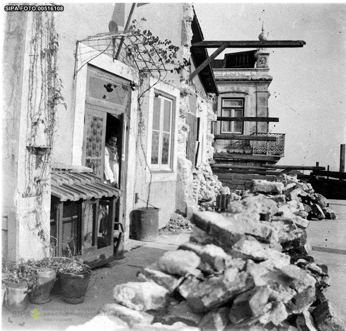
Figura 21: Demolição no casario no piso superior, durante obras de restauro de 1900. (in http://www.monumentos.pt/Site/APP_PagesUser/SIPAArchives.aspx?id=092910cf-8eaa-4aa2-96d9-994cc361eaf1 ) [consultado em 24.01. 2013].
