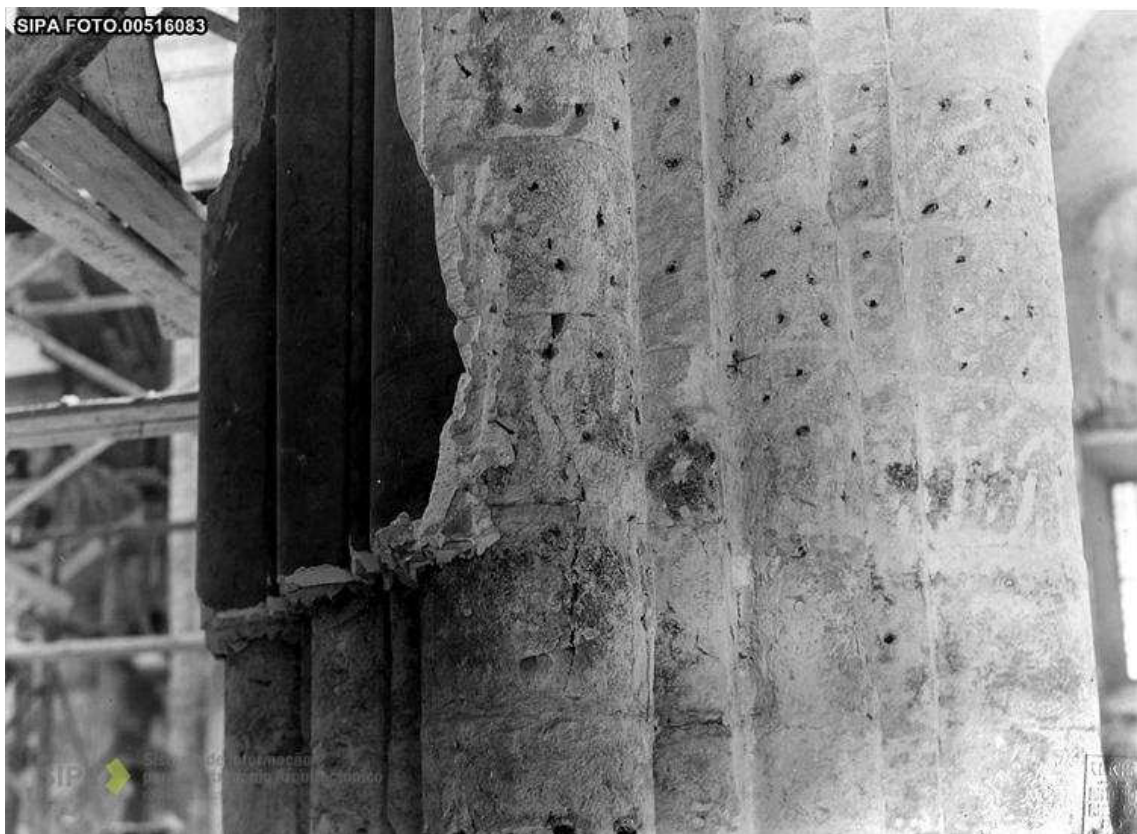
Figura 11: Pormenor da picagem das colunas da nave central, durante obras de restauro de 1900. (in http://www.monumentos.pt/Site/APP_PagesUser/SIPAArchives.aspx?id=092910cf-8eaa-4aa2-96d9-994cc361eaf1 ) [consultado em 24.01. 2013].
