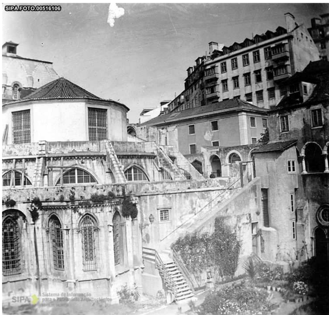
Figura 5: Cabeceira da Sé antes da intervenção das obras de restauro de 1900. (in http://www.monumentos.pt/Site/APP_PagesUser/SIPAArchives.aspx?id=092910cf-8eaa-4aa2-96d9-994cc361eaf1 ) [consultado em 24.01. 2013].
