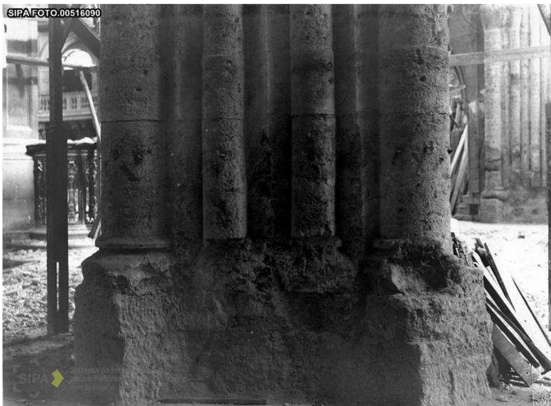
Figura 3: Pormenor de coluna da nave central, durante obras de 1900. (in http://www.monumentos.pt/Site/APP_PagesUser/SIPAArchives.aspx?id=092910cf-8eaa-4aa2-96d9-994cc361eaf1 ) [consultado em 24.01. 2013].
