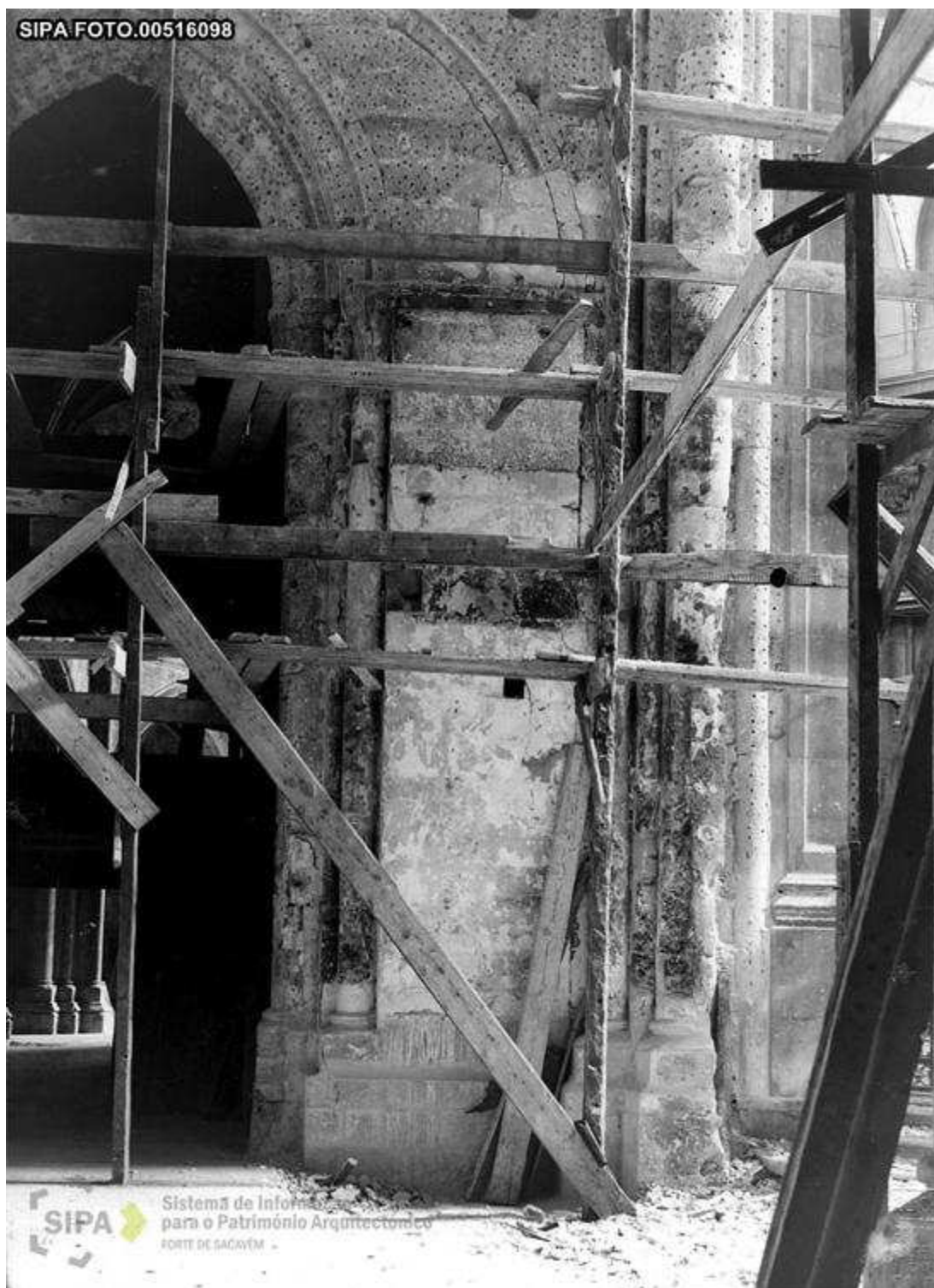
Figura 6: Picagem do arco de acesso ao deambulatório, durante obras de restauro de 1900. (in http://www.monumentos.pt/Site/APP_PagesUser/SIPAArchives.aspx?id=092910cf-8eaa-4aa2-96d9-994cc361eaf1 ) [consultado em 24.01. 2013].
