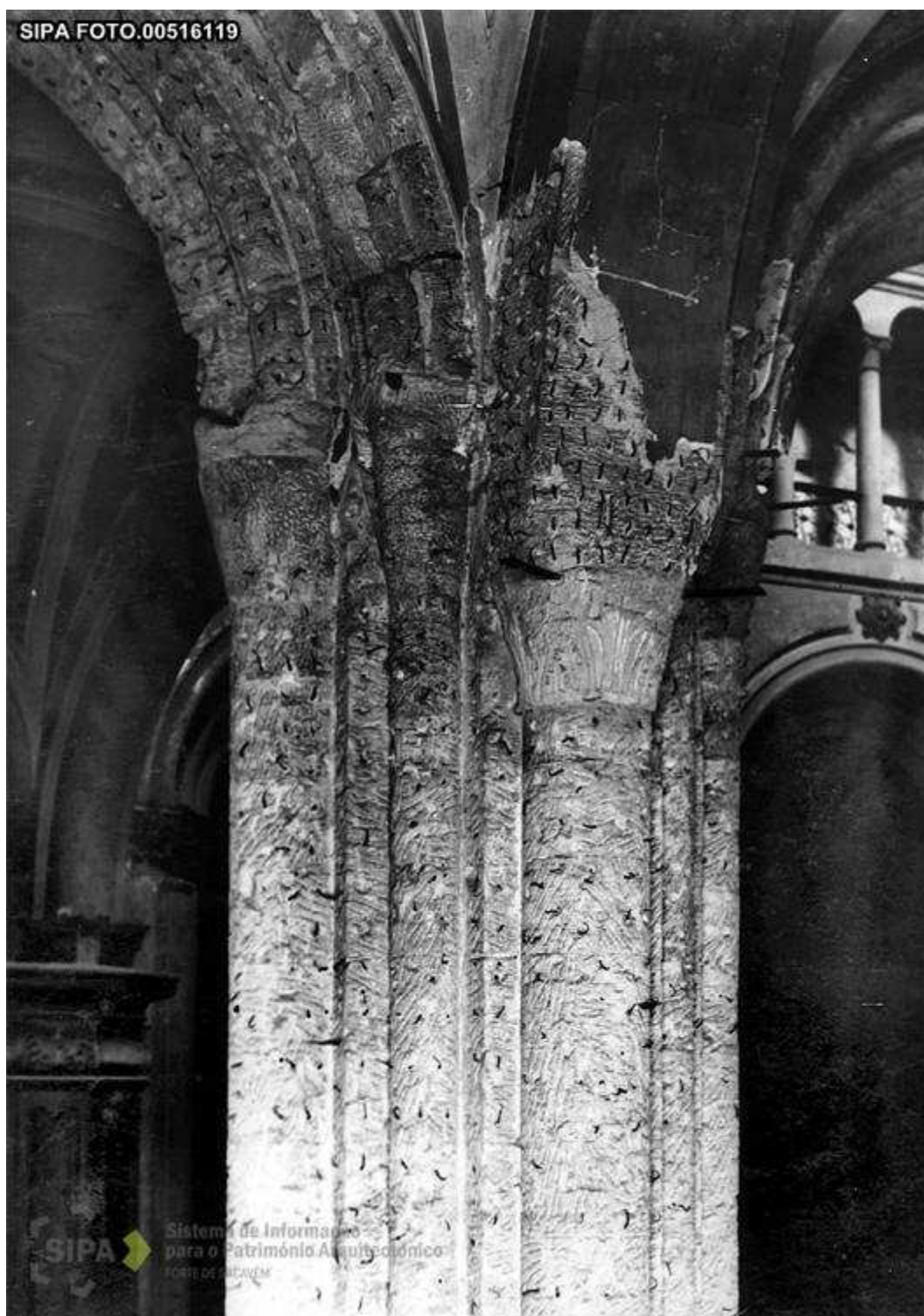
Figura 10: Colunas da Nave, durante obras de restauro de 1900. (in http://www.monumentos.pt/Site/APP_PagesUser/SIPAArchives.aspx?id=092910cf-8eaa-4aa2-96d9-994cc361eaf1 ) [consultado em 24.01. 2013].
