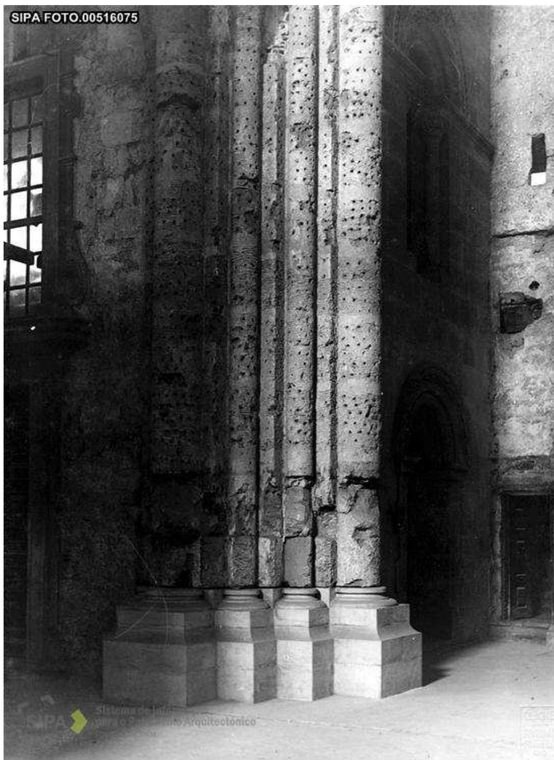
Figura 9: Coluna da nave lateral e transepto com a base de cantaria substituída, durante obras de restauro de 1900. (in http://www.monumentos.pt/Site/APP_PagesUser/SIPAArchives.aspx?id=092910cf-8eaa-4aa2-96d9-994cc361eaf1 ) [consultado em 24.01. 2013].
