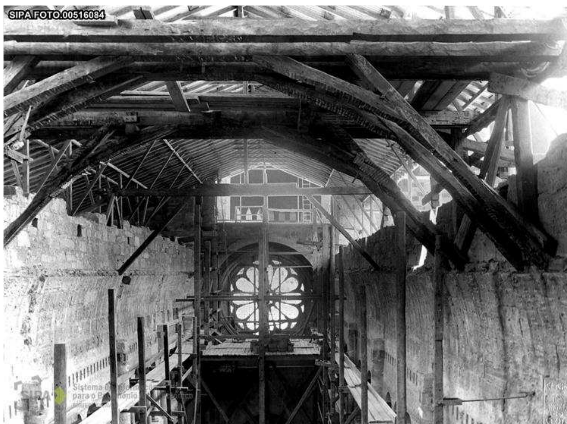
Figura 8: Nave central, durante obras de restauro de 1900. (in http://www.monumentos.pt/Site/APP_PagesUser/SIPAArchives.aspx?id=092910cf-8eaa-4aa2-96d9-994cc361eaf1 ) [consultado em 24.01. 2013].
