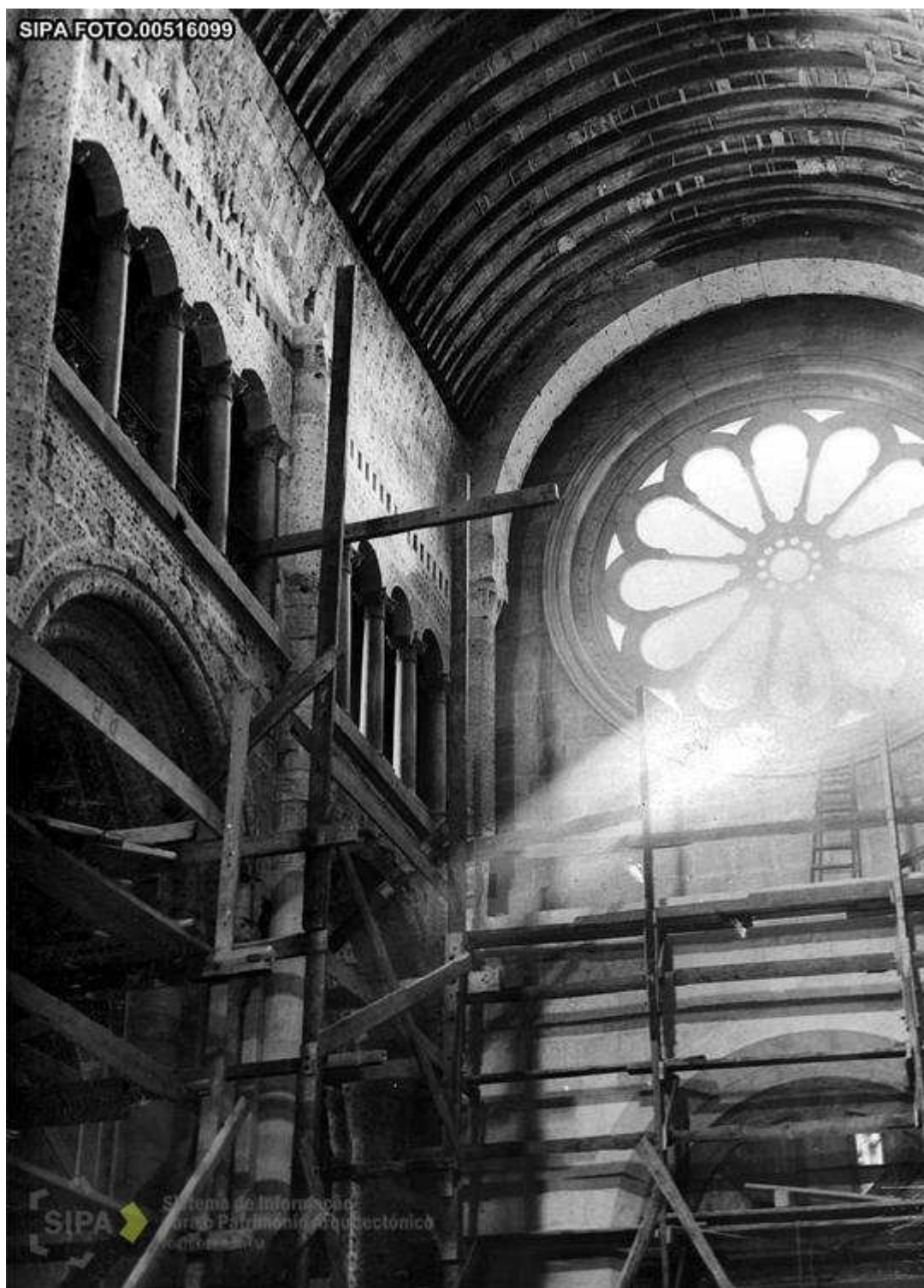
Figura 13: Rosácea e coro alto, durante as obras de restauro de 1900. (in http://www.monumentos.pt/Site/APP_PagesUser/SIPAArchives.aspx?id=092910cf-8eaa-4aa2-96d9-994cc361eaf1 ) [consultado em 24.01. 2013].
