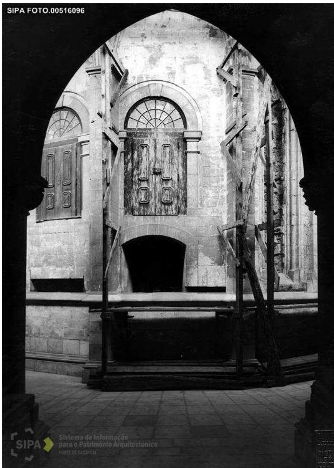
Figura 14: Janelas do deambulatório, durante obras de restauro de 1900. (in http://www.monumentos.pt/Site/APP_PagesUser/SIPAArchives.aspx?id=092910cf-8eaa-4aa2-96d9-994cc361eaf1 ) [consultado em 24.01. 2013].
