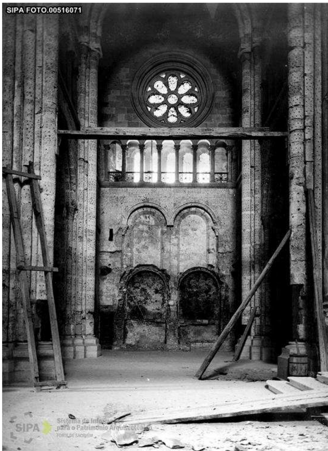
Figura 18: Transepto durante obras de restauro de 1900, lado norte. (in http://www.monumentos.pt/Site/APP_PagesUser/SIPAArchives.aspx?id=092910cf-8eaa-4aa2-96d9-994cc361eaf1 ) [consultado em 24.01. 2013].
