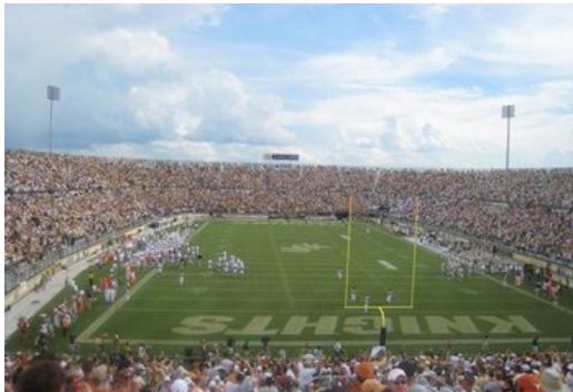
(a) Vista geral do Estádio Bright House Networks [5]
