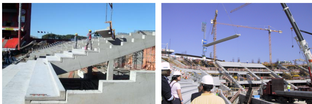
Figura 5.2: Colocação de bancadas nos pórticos principais [66]
