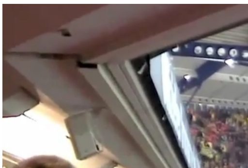
(b) Vista inferior da bancada superior, onde se notam os deslocamentos excessivos [6]
