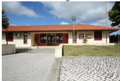
Centro de Saúde Figueiró dos Vinhos
