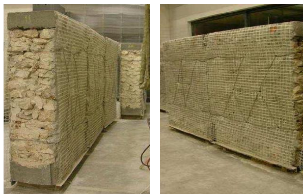
Figura 2.18 - Aspeto dos muretes da solução de reforço IV, antes do início da aplicação da segunda camada de argamassa [24, 75]
