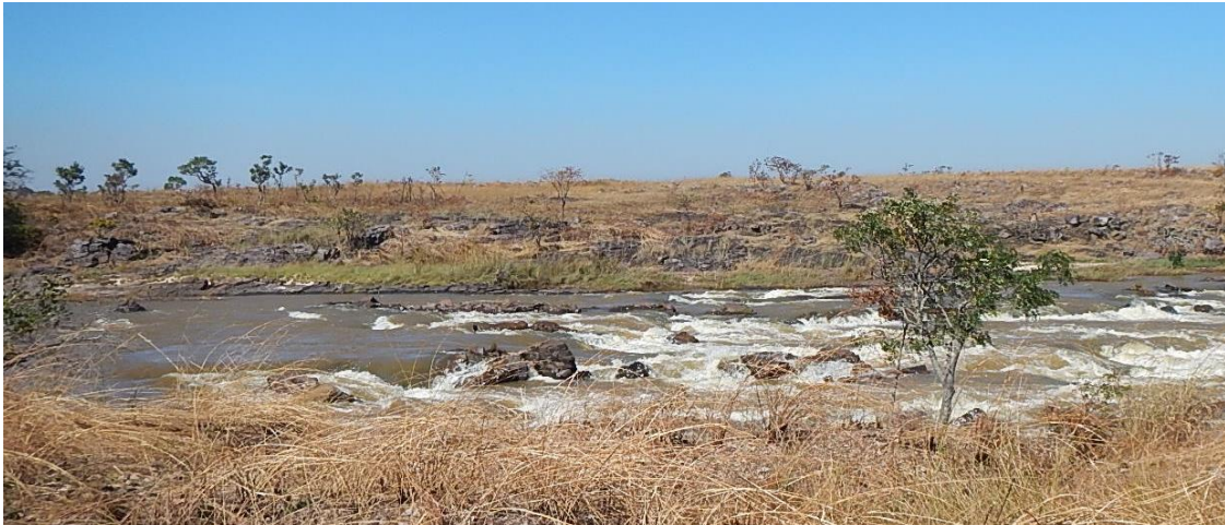
Figura 5.4 Aspecto geral da fundação da barragem (Retirado de [22])
