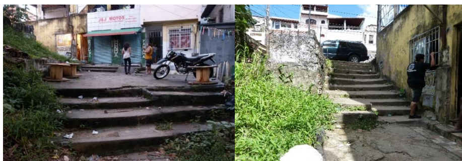
Figura 60a e 61b - Imagens da escada antes da intervenção. Enviada pelo grupo por e-mail em setembro de 2018
