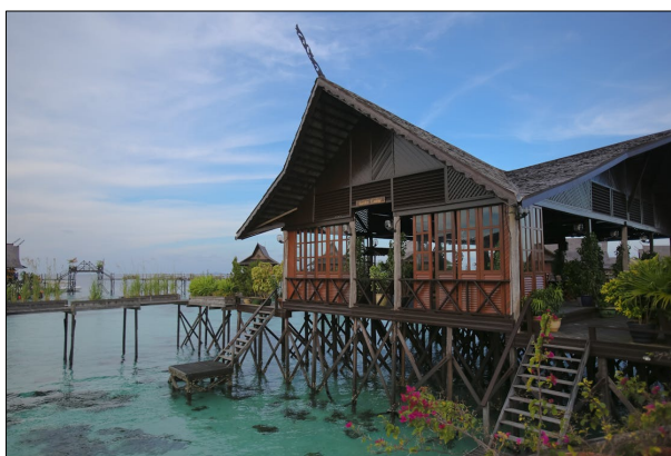
Figura 2.3 – Edifício em palafita, Malásia Fonte: Vitalina (2013)
